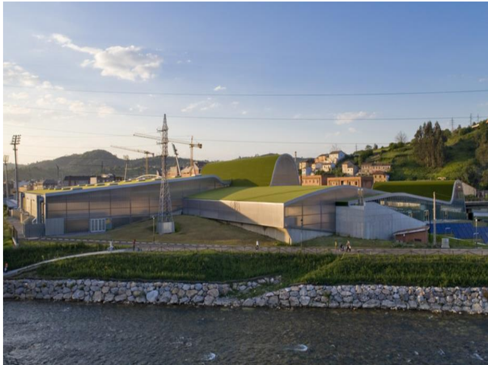
Figura 51. Vista exterior de sistema de iluminación natural a través de muro cortina del Centro de Langreo
