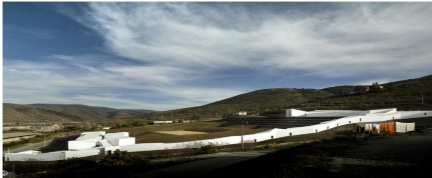
Figura 29. Vista Fachada Centro Remo Do pocinho
