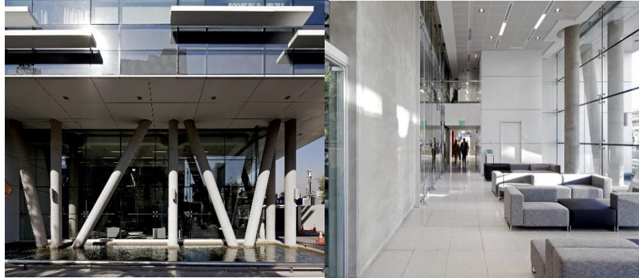
Figura 34. Vista interior y exterior Centro Manquehue
