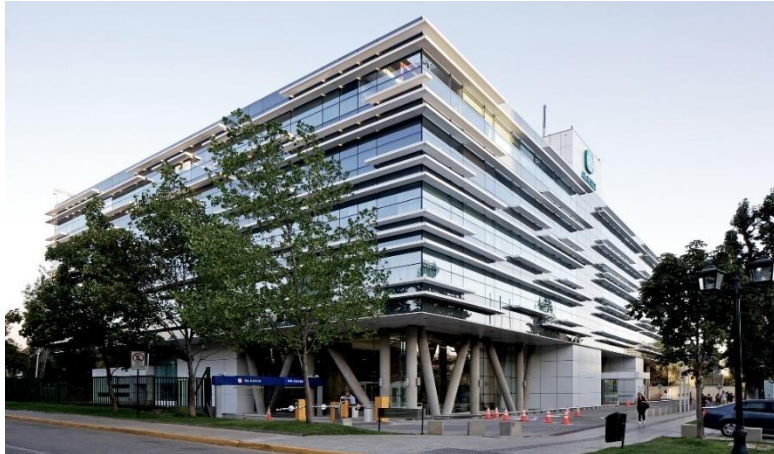
Figura 32. Vista Fachada Centro Manquehue
