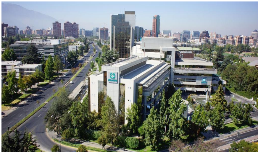
Figura 30. Vista Fachada Centro Manquehue
