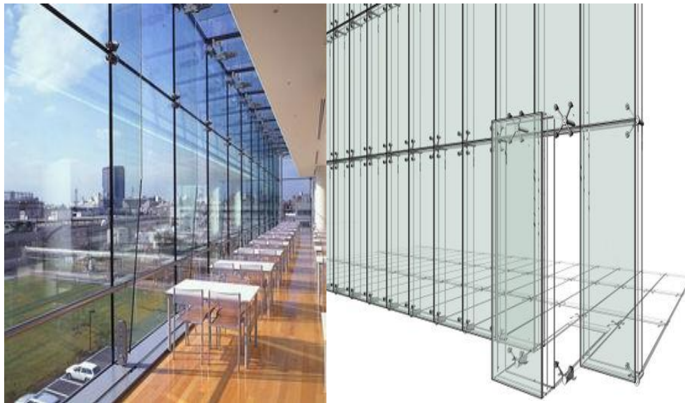
Figura 132. Ilustración de vidrio con sistema spider
