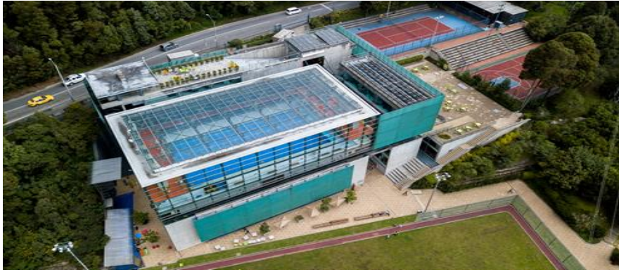
Figura 19. Vista Cenital Fachada Centro de los Andes
