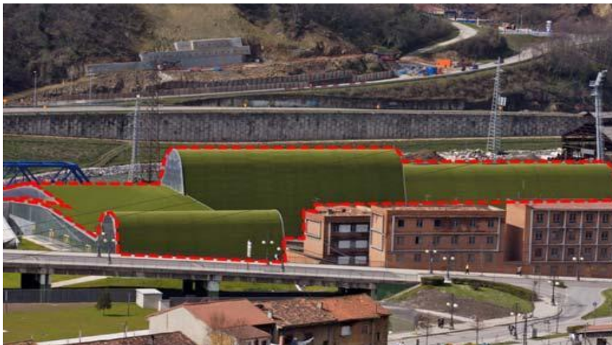
Figura 11. Vista fachada posterior
