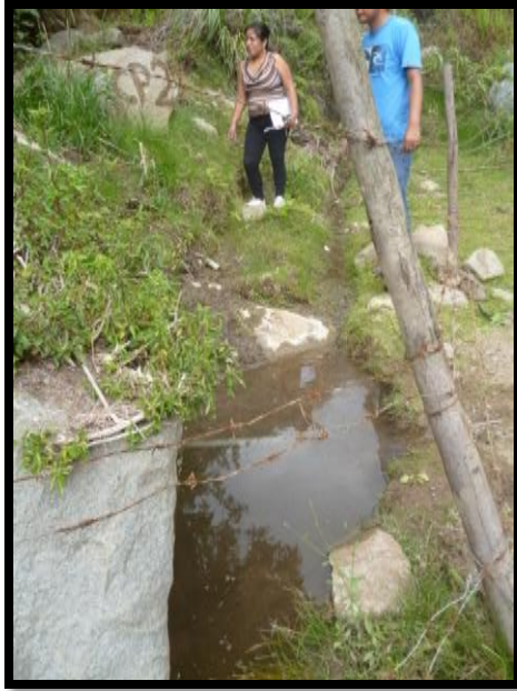
SEGUNDA CAPTACION DE AGUA CP2
