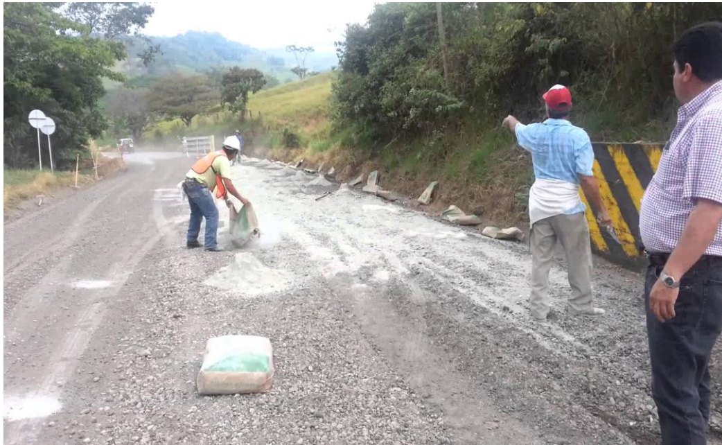
Figura N° 13 Base estabilizada con cemento.
