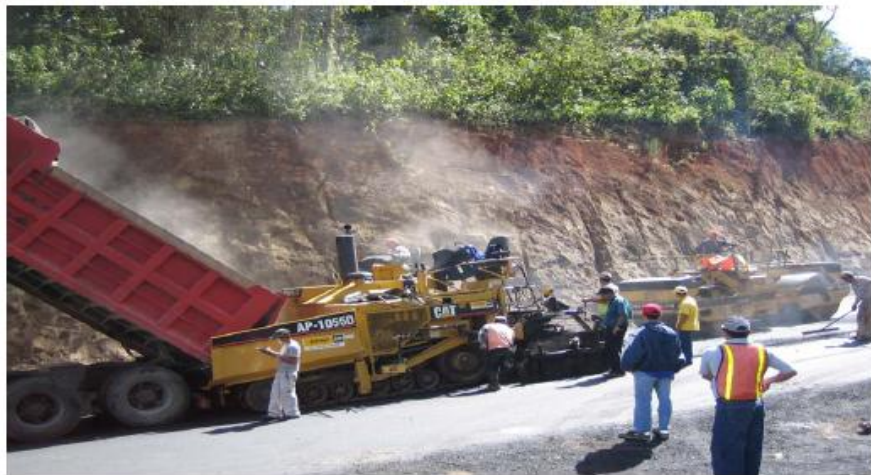
Figura 2. Aplicación de mezcla asfáltica modificada
