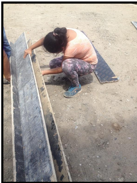
FIGURA 21: Preparación de encofrado para las probetas prismáticas de concreto
