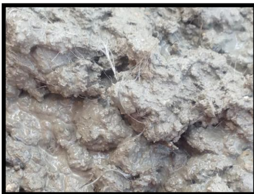
FIGURA 20: Mezcla de concreto con adición de 1000gr de Polipropileno por metro cúbico
