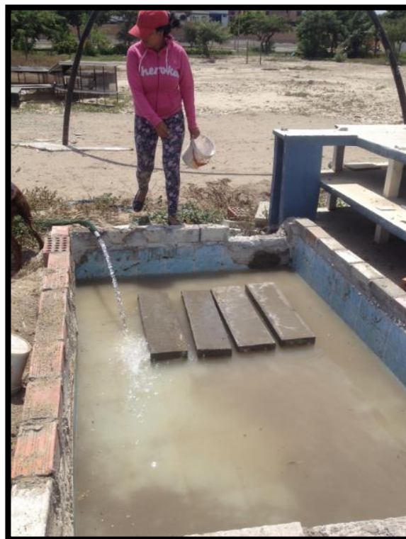
FIGURA 24: Proceso de curado en el Pozo de Curado de la Universidad Nacional de Trujillo
