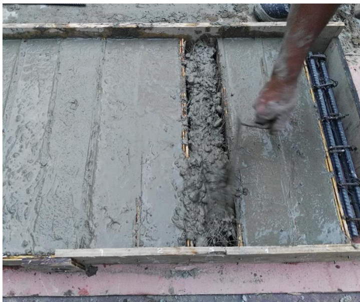
Construcción de Muestras de Columnas
