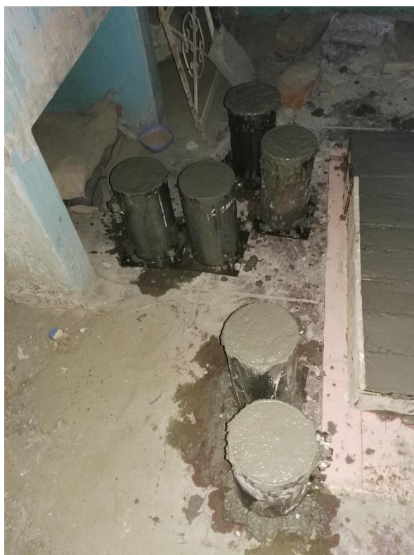
Construcción de Probetas de Concreto
