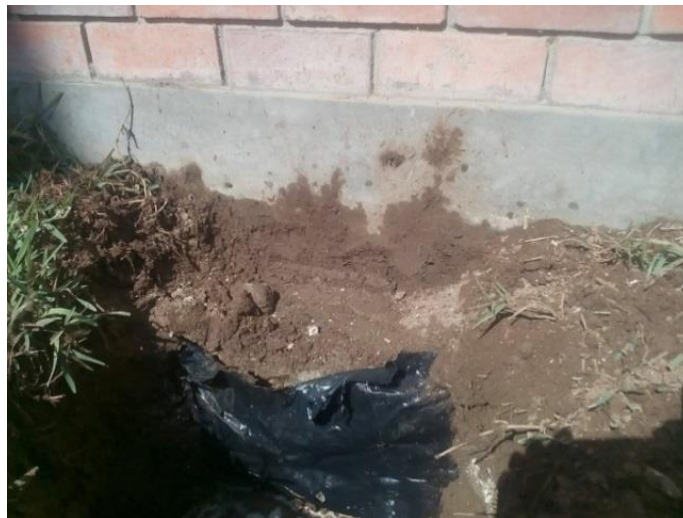
Figura N° 31: Material plástico que cubre los cimientos.
