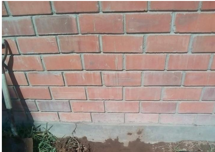
Figura N° 29: Muro de ladrillos que no presenta humedad.
