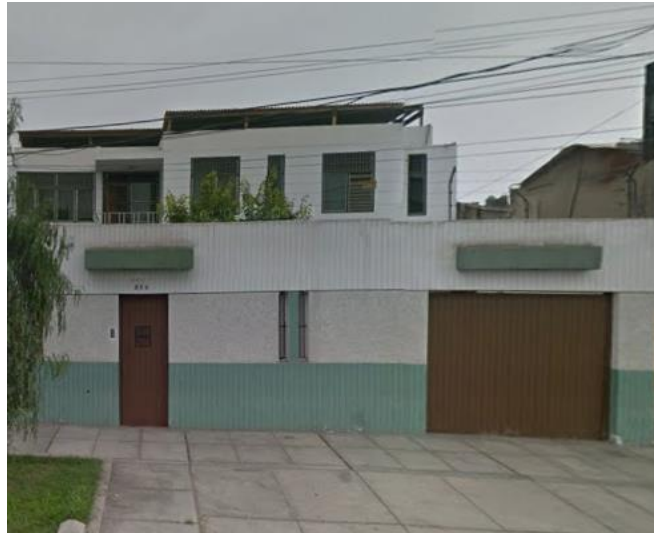
Figura N° 28: Casa de material noble que no presenta humedad, por los procedimientos constructivos previos para evitar la humedad por capilaridad.
