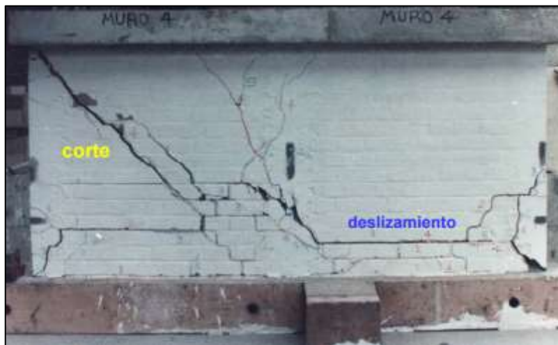
Figura 8. Falla por corte, debido a la tracción diagonal y deslizamiento (San Bartolomé).
