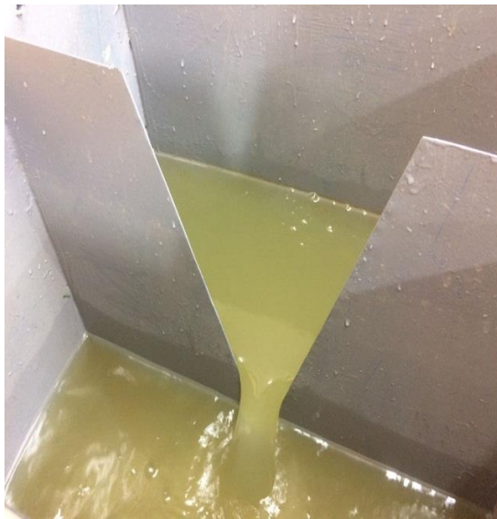
Figura N° 5-29. Vertedero Triangular
