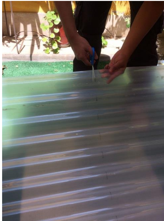
Figura N° 5-5. Medidas y corte a la calamina
