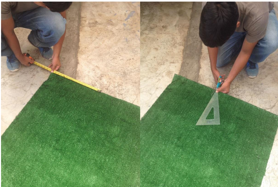
Figura N° 5-5. Medidas y corte al grass sintético
