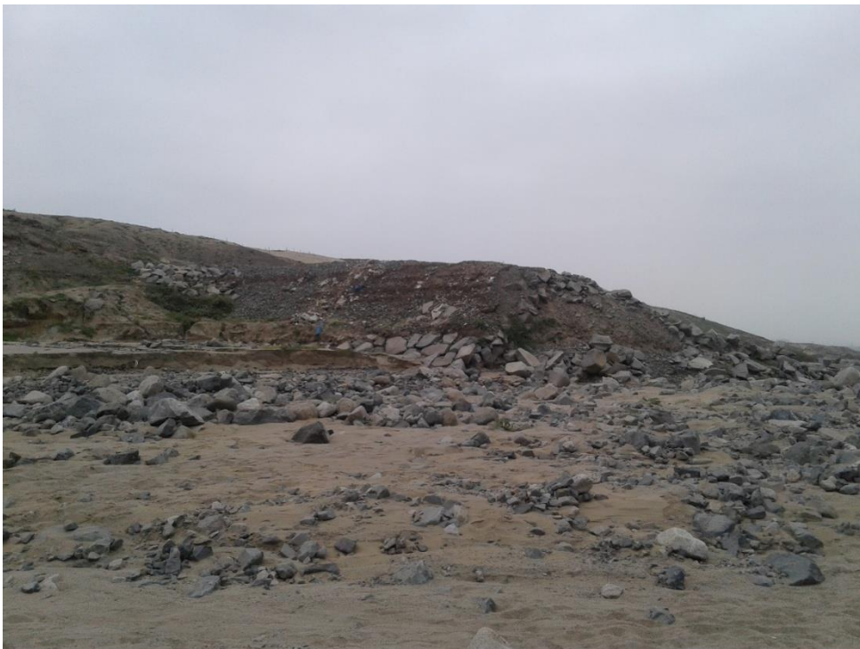
Fotografía: Deterioro de dique después del fenómeno ocurrido en marzo 2017, abril 2017
