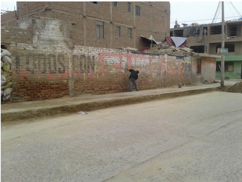
Fotografía: Medición de la altura de huella de agua, en ingreso al El Porvenir, abril 2017
