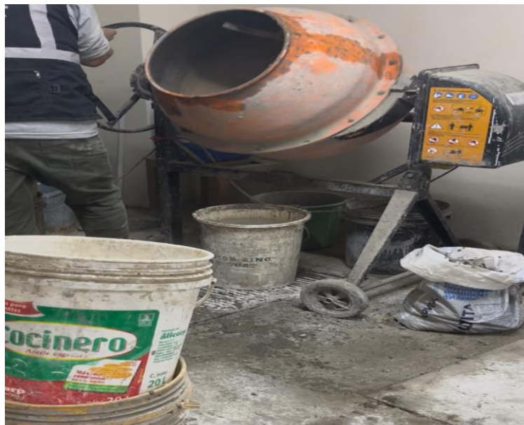
Imagen 10. Preparación del concreto.
