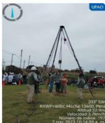
Ensayo SPT 01 en proceso
