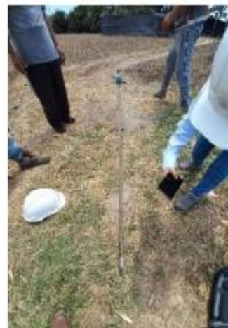
Barreta que evidencia la presencia de Napa Freática.
