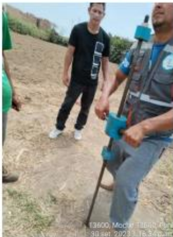
Ensayo DPL 01 en proceso
