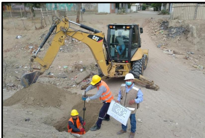
Excavación con maquinaria a 3.00m de profundidad para ensayo DPL.
