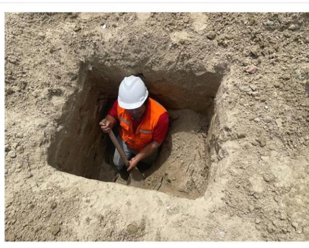
Imagen 4. Excavación para calicata.
