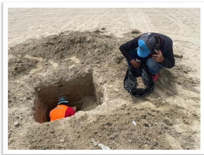
Imagen 3. Excavación para calicata.
