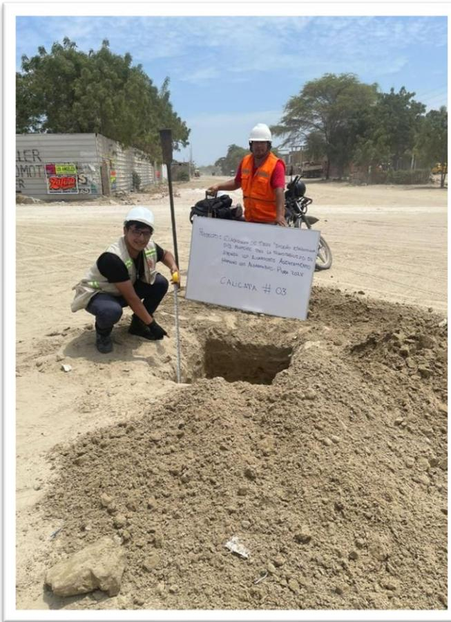
Imagen 1. Excavación para calicata.
