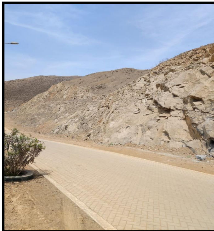
Panel fotográfico del talud -2.
