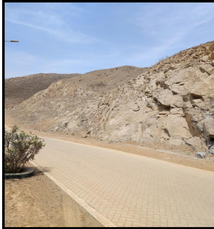
Panel fotográfico del talud -1.
