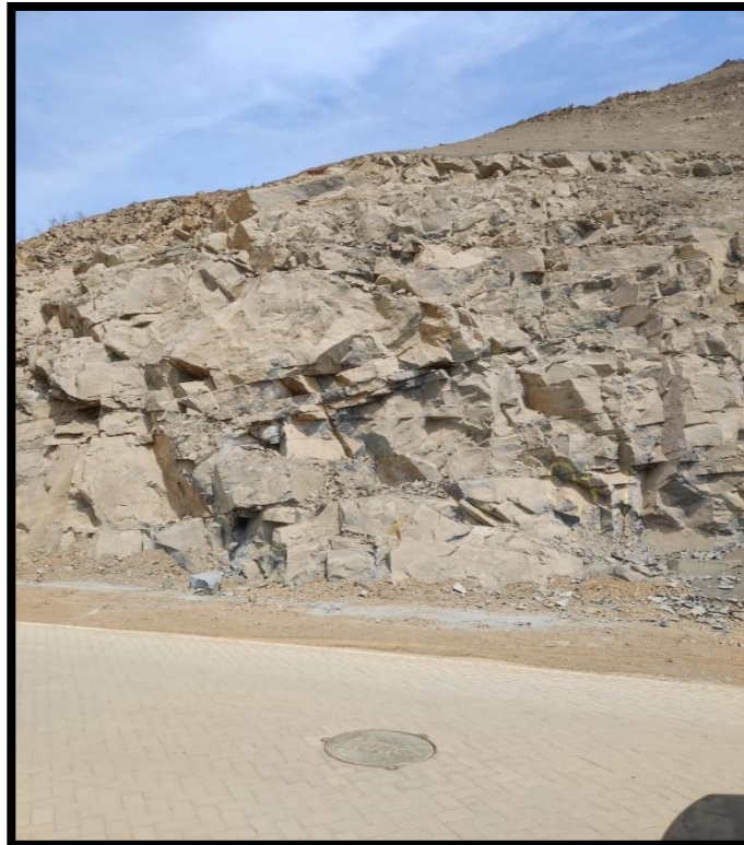
Panel fotográfico del talud -3.
