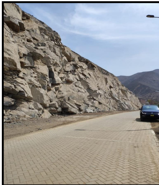
Panel fotográfico del talud -4.
