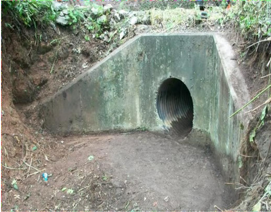
Fotografía N° 07: Vista de alcantarilla limpia y libre de maleza
