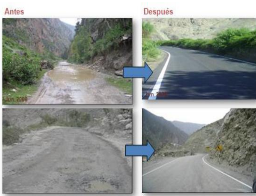
Fotografía N° 12: Antes y Después .Corredor vial Cañete – Yauyos.
