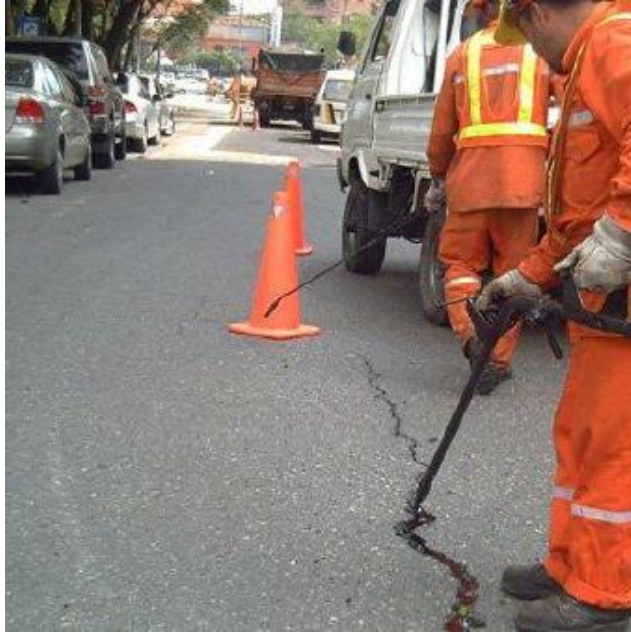
Fotografía N°03: Actividad de tratamiento de fisuras.
