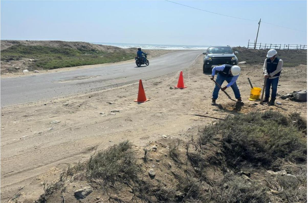
Foto 10: Excavación de calicata 03
