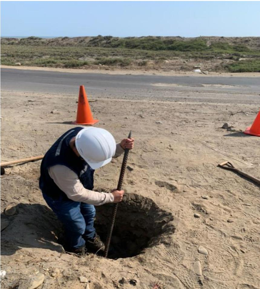
Foto 11: Excavación de calicata 04
