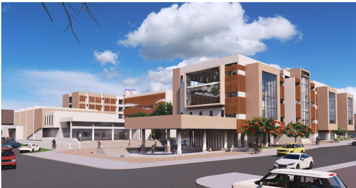
Figura N° 43: Vista fachada CA. 25 de diciembre - Zona cultural
