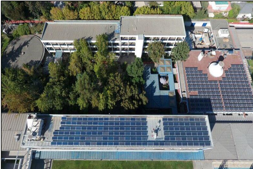
Figura 13 PANELES SOLARES EN CENTRO EDUCATIVO
