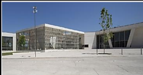
Acceso Primaria y Secundaria.
