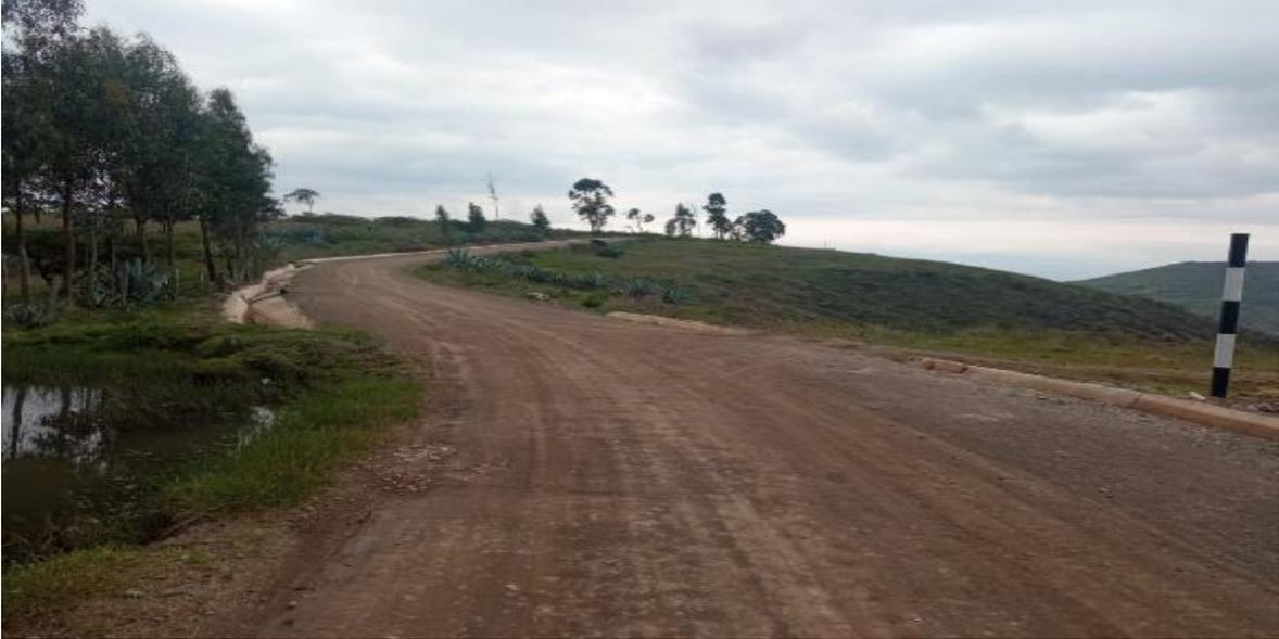
*Nota:* La figura muestra la presencia de saturación en la progresiva 0+140.00 debido a que se encuentra al lado de una captación de agua sin ser aislada del afirmado, lo que hace que la superficie de rodadura sea inestable.
