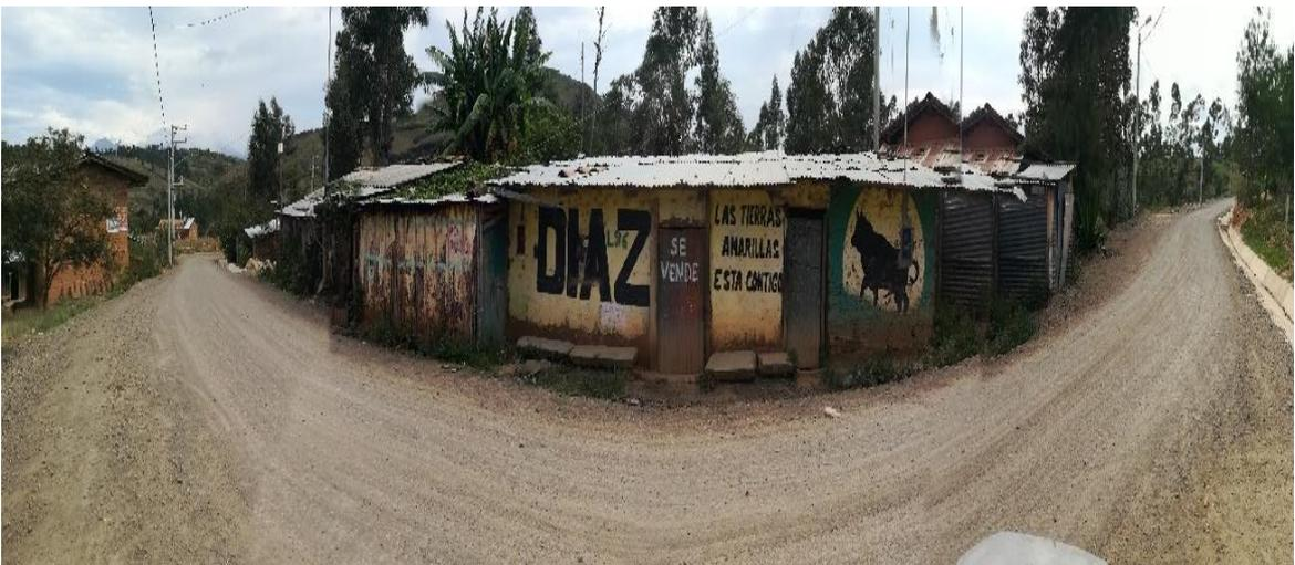
*Nota:* La figura muestra presencal de ahuellamiento en la progresiva 0+200.00 debido a las constantes lluvias y a los malos trabajos de compactación al borde del carril.
