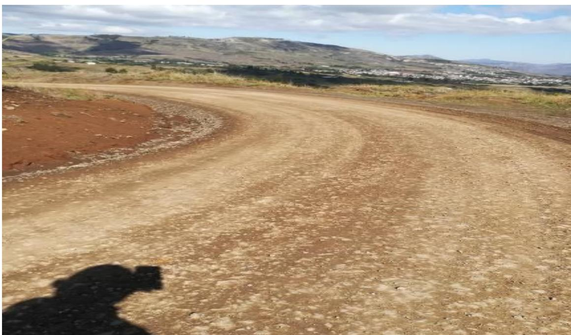
*Nota:* La figura muestra la progresiva 2+700.00 debido a las constantes lluvias y a los malos trabajos de compactación al borde del carril. Podemos notar la progresiva ausencia de material fino en el afirmado.
