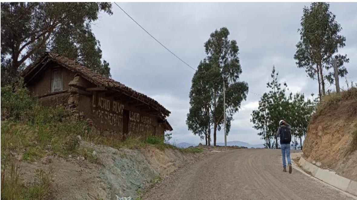
*Nota:* La figura muestra la progresiva 3+700.00 debido a las constantes lluvias y a los malos trabajos de compactación al borde del carril. Podemos notar la progresiva ausencia de material fino en el afirmado.
