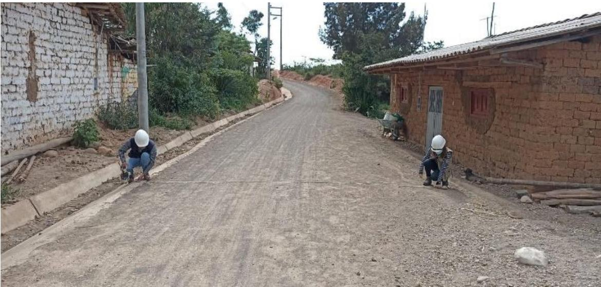
*Nota:* La figura muestra que se corroboró que la superficie de rodadura cuenta con el ancho mínimo de vía establecido por la DG-2018 de 6.60 metros para una Carretera de Tercera Clase.
