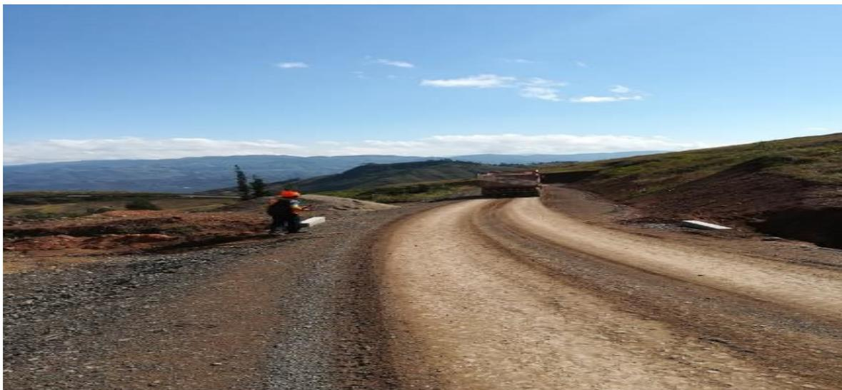
*Nota:* La figura muestra presencal de ahuellamiento en la progresiva 2+500.00 debido a las constantes lluvias y a los malos trabajos de compactación al borde del carril. Podemos notar la progresiva ausencia de material fino en el afirmado.
