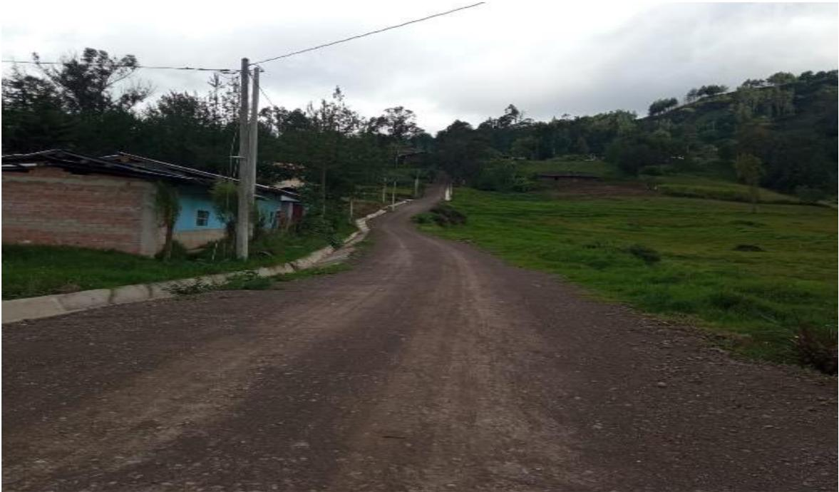
*Nota:* La figura muestra el Caserío de Mitopampa donde en la mayoría del tiempo ocurren lluvias muy fuertes; ocasionando que la superficie de rodadura sea afectada, de tal forma que la presencia de material fino sea menor conforme pasan las lluvias
