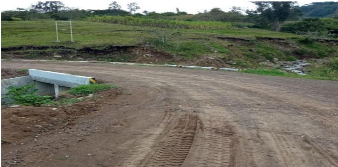
*Nota:* La figura muestra la excesiva presencia de material limoso, lo que hace de este tramo inestable y peligroso para el transporte vehicular. La presencia de ahuellamiento es muy propensa a notarse en un lapso de tiempo más corto.
