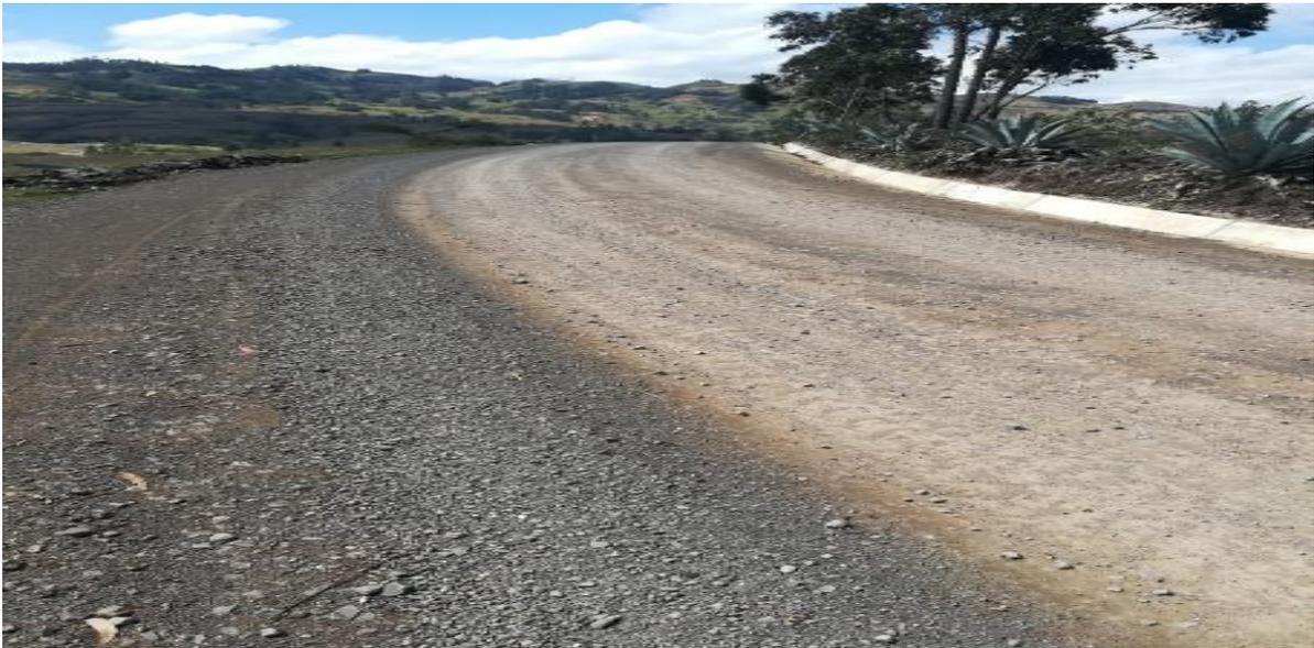
*Nota:* La figura muestra presencial de ahuellamiento en la progresiva 0+900.00 debido a las constantes lluvias y a los malos trabajos de compactación al borde del carril. Podemos notar la progresiva ausencia de material fino en el afirmado.
