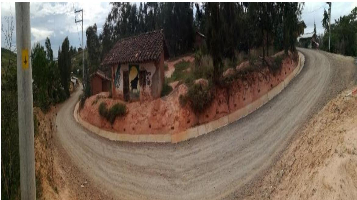
*Nota:* La figura muestra presencia de ahuellamiento en la progresiva 0+160.00 debido a las constantes lluvias y a los malos trabajos de compactación al borde del carril.
