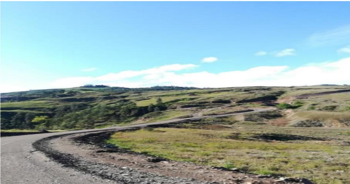
*Nota:* La figura muestra la progresiva 2+000.00, la cual es propensa a erosionar en su totalidad debido a la mala compactación y a su talud elevado, lo que dejaría expuesta a la alcantarilla
