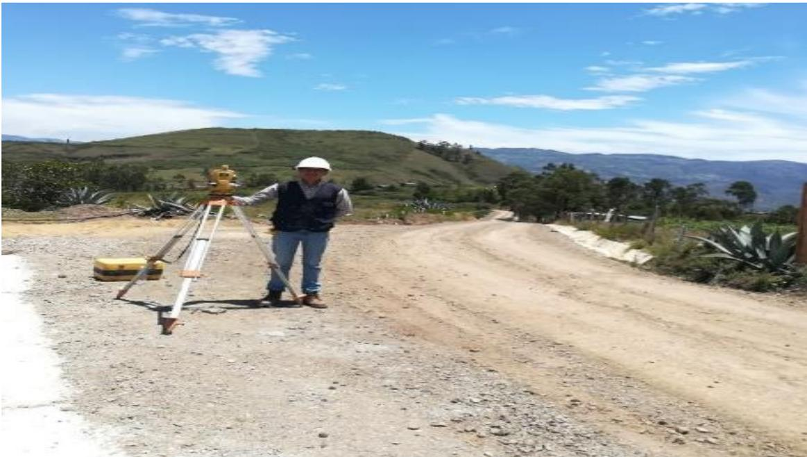
*Nota:* La figura muestra que se realizó el levantamiento topográfico en el tramo inicial del Camino Vecinal, progresiva 0+800.00 por medio de una Estación Total.
