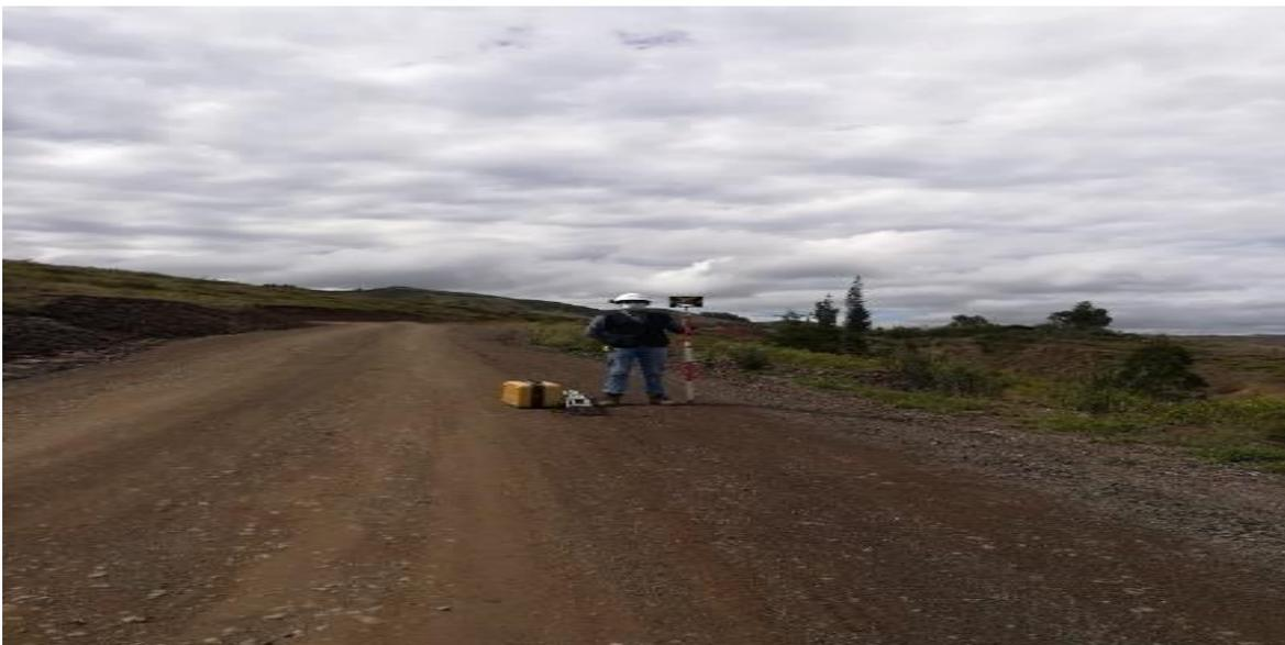
*Nota:* La figura muestra que se realizó el levantamiento topográfico en el tramo inicial del Camino Vecinal, progresiva 2+450.00 por medio de una Estación Total.
