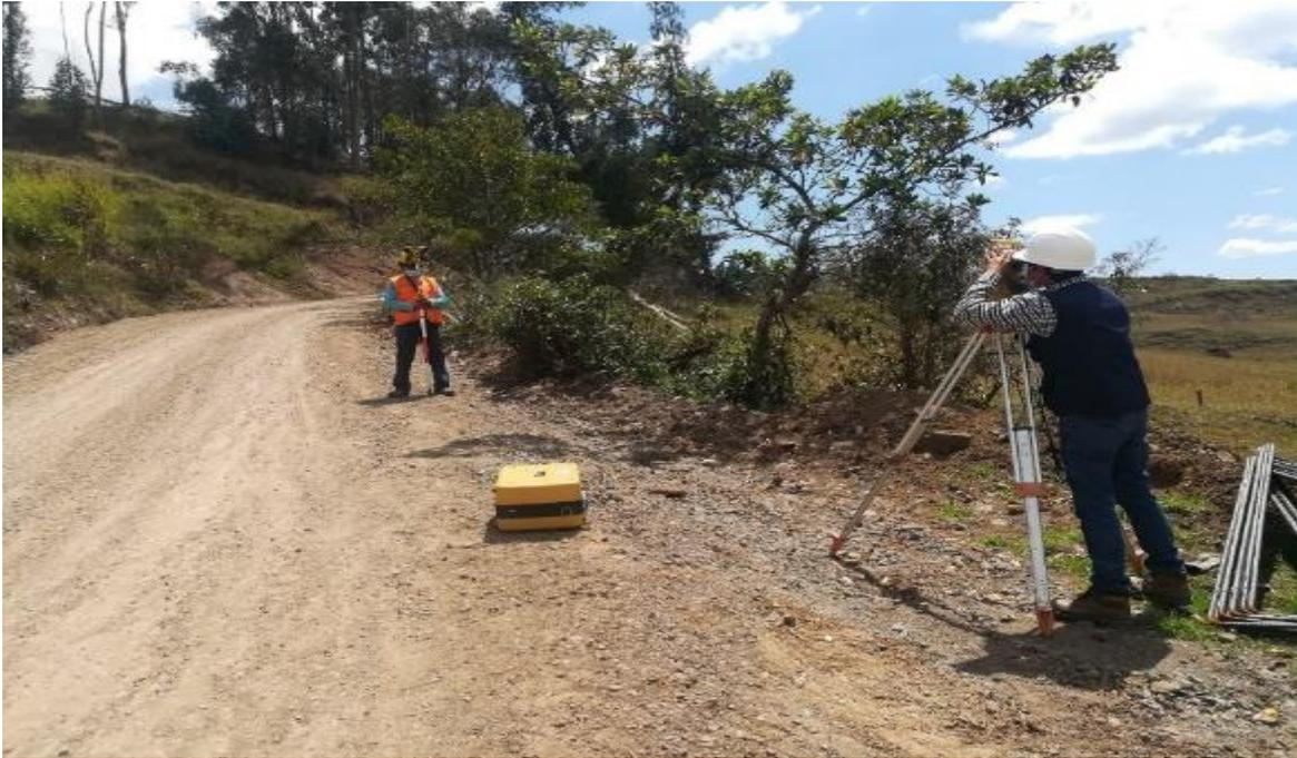
*Nota:* La figura muestra que se realizó el levantamiento topográfico en el tramo inicial del Camino Vecinal, progresiva 4+950.00 por medio de una Estación Total.
