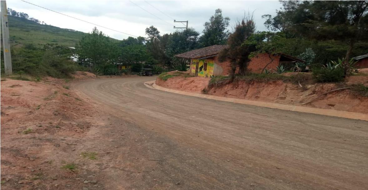
*Nota:* La figura muestra presencal de ahuellamiento en la progresiva 0+140.00 debido a las constantes lluvias y a los malos trabajos de compactación al borde del carril.
