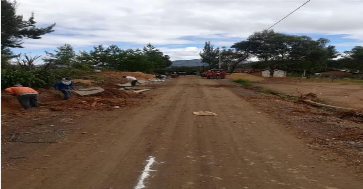
*Nota:* La figura muestra presencias de ahuellamiento en la progresiva 0+320.00 debido a las constantes lluvias y a los malos trabajos de compactación al borde del carril.
