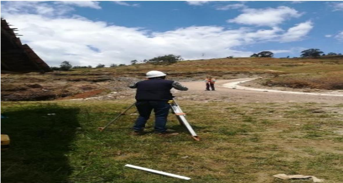
*Nota:* La figura muestra que se realizó el levantamiento topográfico en el tramo inicial del Camino Vecinal, progresiva 5+280.00 por medio de una Estación Total.
