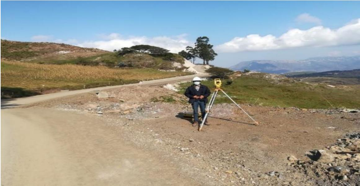
*Nota:* La figura muestra que se realizó el levantamiento topográfico en el tramo inicial del Camino Vecinal, progresiva 3+560.00 por medio de una Estación Total.
