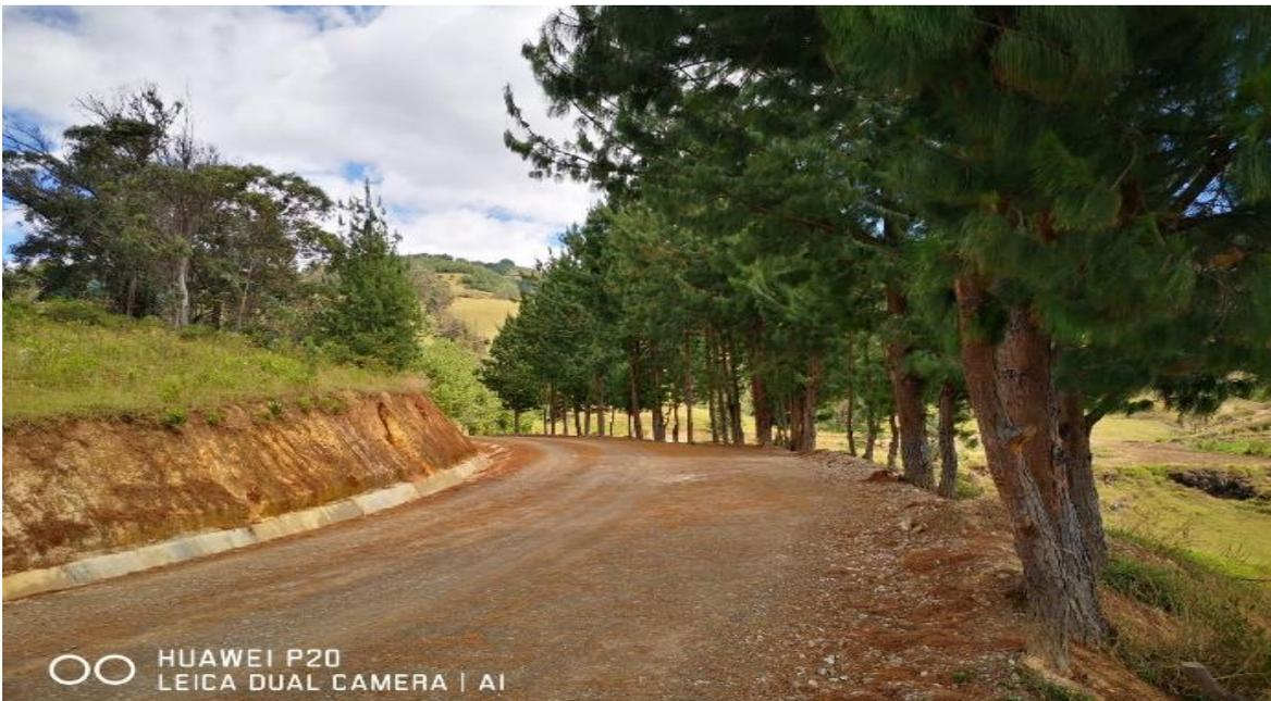
*Nota:* La figura muestra la excesiva presencia de material limoso, lo que hace de este tramo inestable y peligroso para el transporte vehicular. La presencia de ahuellamiento es muy propensa a notarse en un lapso de tiempo más corto.
