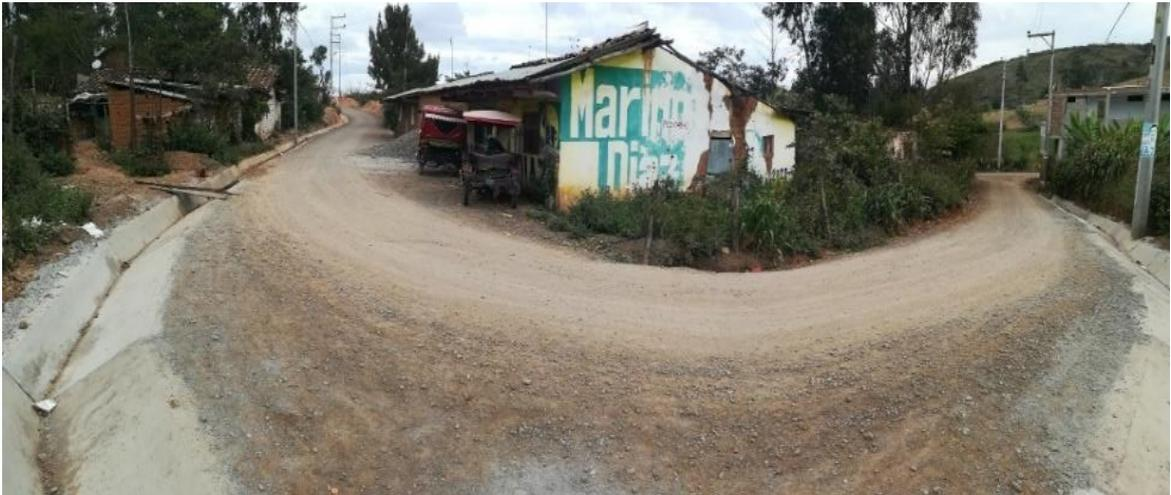
*Nota:* La figura muestra presencia de ahuellamiento en la progresiva 0+050.00 debido a las constantes lluvias y a los malos trabajos de compactación al borde del carril.
