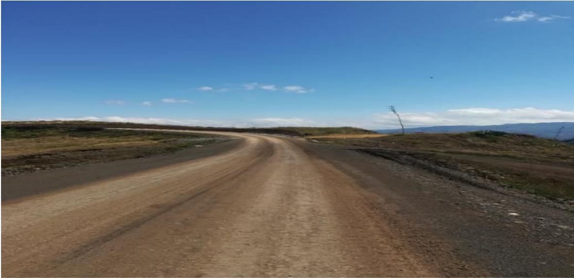
*Nota:* La figura muestra la progresiva 2+200.00, este tramo se encuentra debidamente compactado y pese a que en los bordes están aparentemente sin compactar estos ya no forman parte de la superficie de rodadura, este tramo cuenta con un ancho de aproximadamente 9.00 metros
