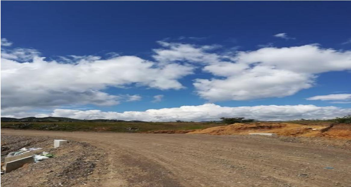
*Nota:* La figura muestra la progresiva 0+800.00, la cual es propensa a erosionar en su totalidad debido a la mala compactación y a su talud elevado, lo que dejaría expuesta a la alcantarilla
