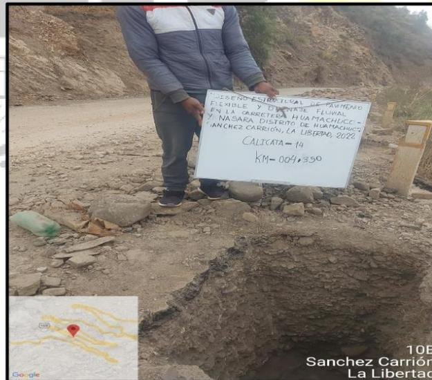
Fotografía N°14: Excavación de Calicata 14.
