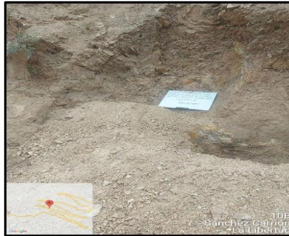
**Fotografía N°11: Excavación de Calicata 11.**
