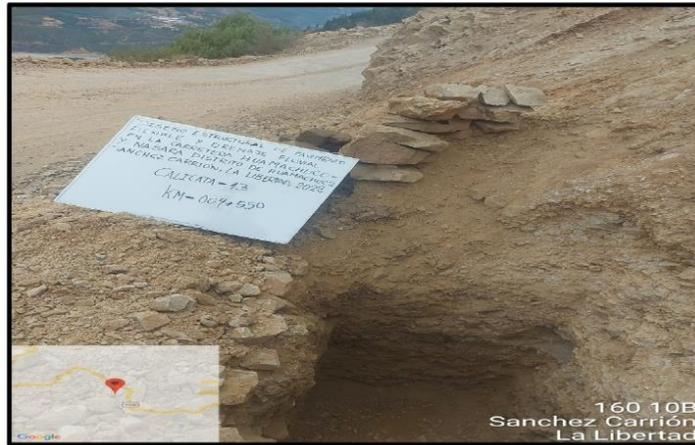
Fotografía N°13: Excavación de Calicata 13.
