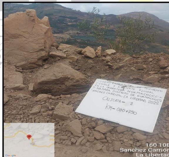
**Fotografía N°02: Excavación de Calicata 02.**
