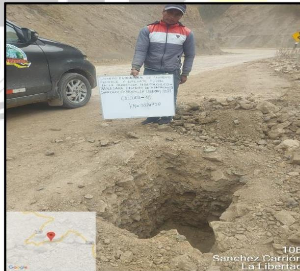
Fotografía N°10: Excavación de Calicata 10.
