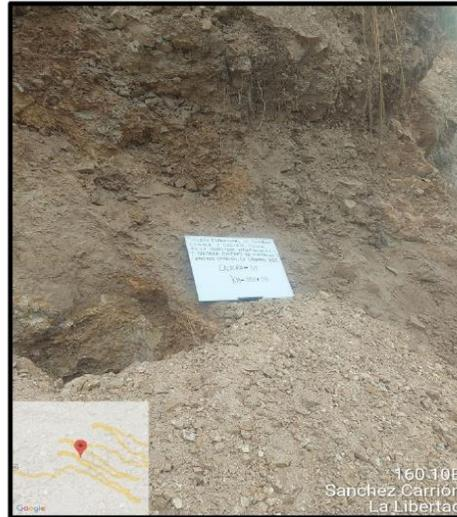
**Fotografía N°01: Excavación de Calicata 01.**
