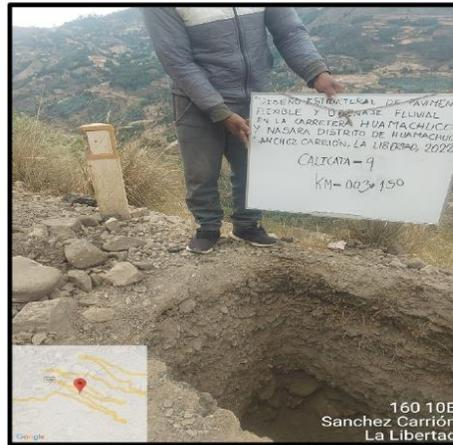
Fotografía N°09: Excavación de Calicata 09.
