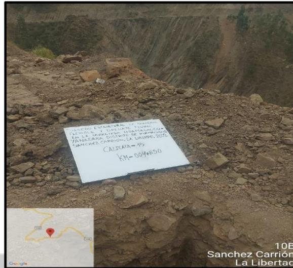
Fotografía N°15: Excavación de Calicata 15.
