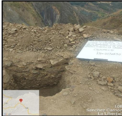
Fotografía N°05: Excavación de Calicata 05.
