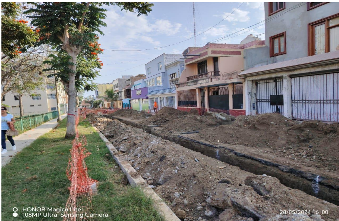
FIGURA 18: Excavación de zanjas de redes de tuberías de desagüe
