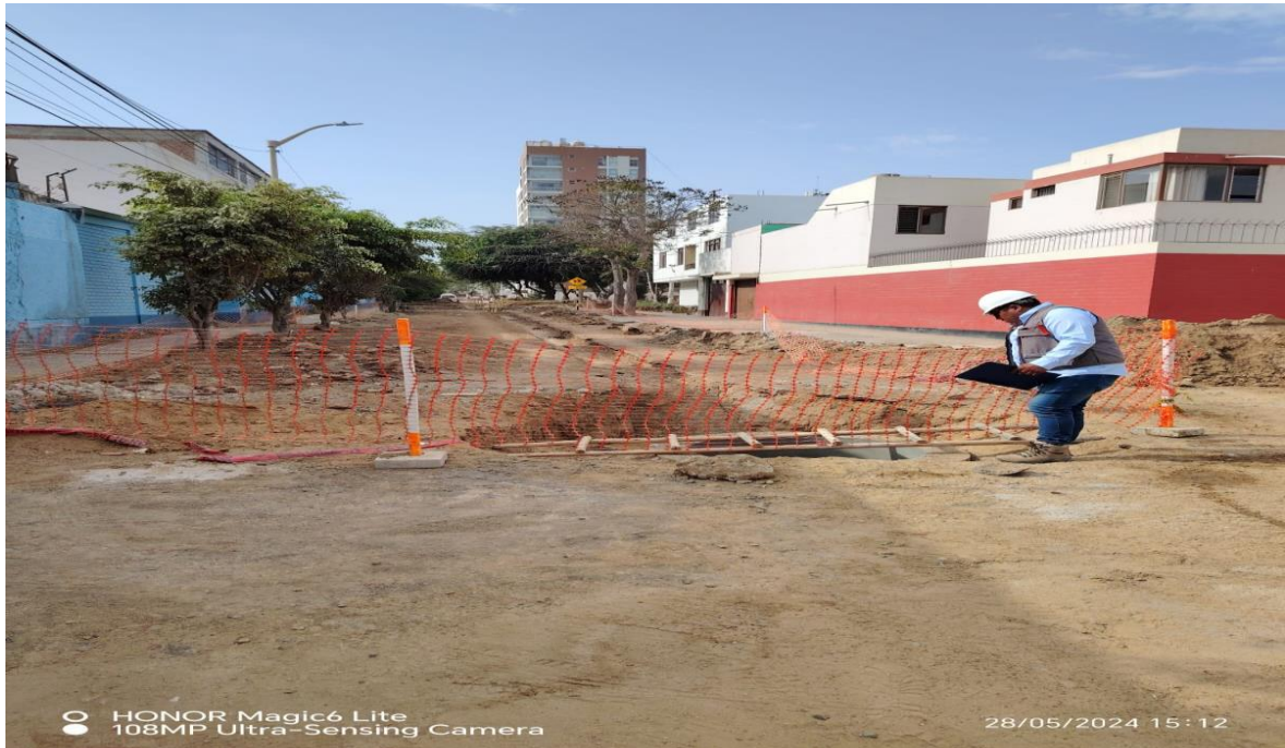
FIGURA 3: Desencofrado de Buzón
