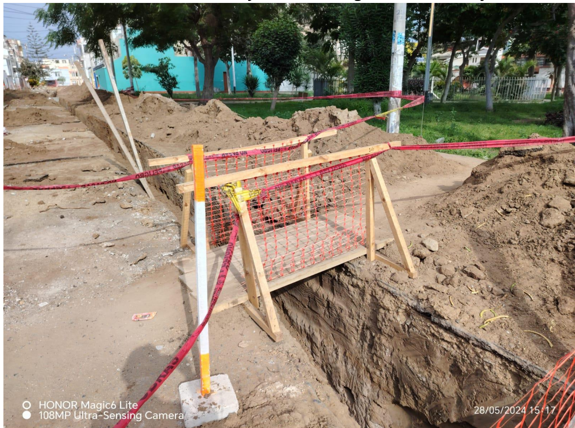
FIGURA 6: Circulación de cintas y mallas de seguridad en la zanjas
