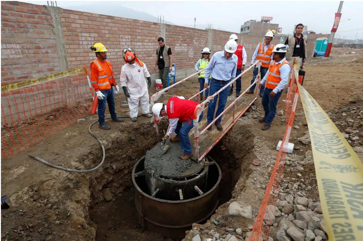
FIGURA 21: Vaciado de buzones en presencia de los ingenieros
