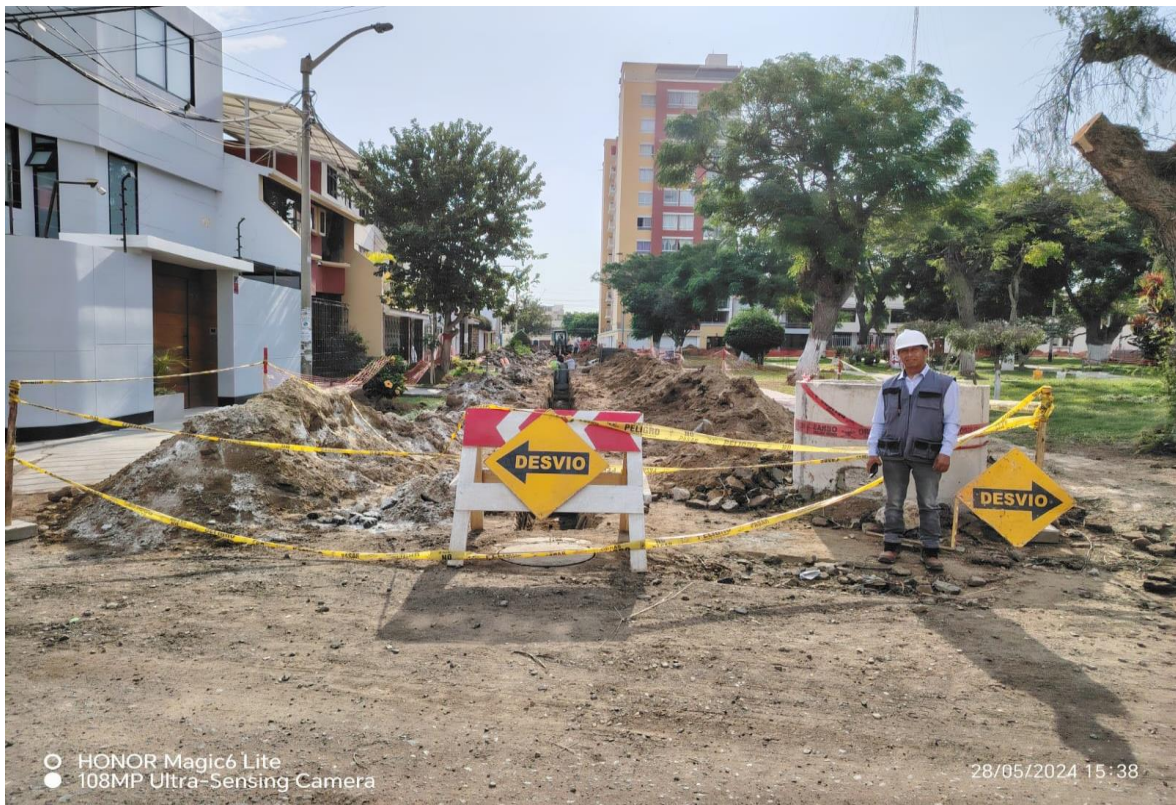
FIGURA 10: Aplanamiento de afirmado en las zanjas de desagüe
