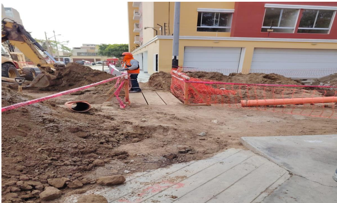
FIGURA 16: Movimiento de tierras en las zanjas
