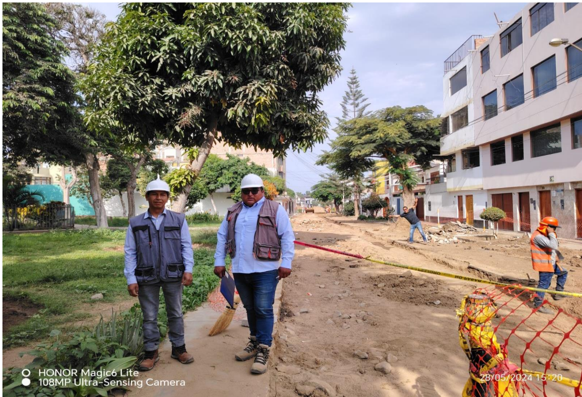
FIGURA 11: Movimiento de tierras en las zanjas de desagüe
