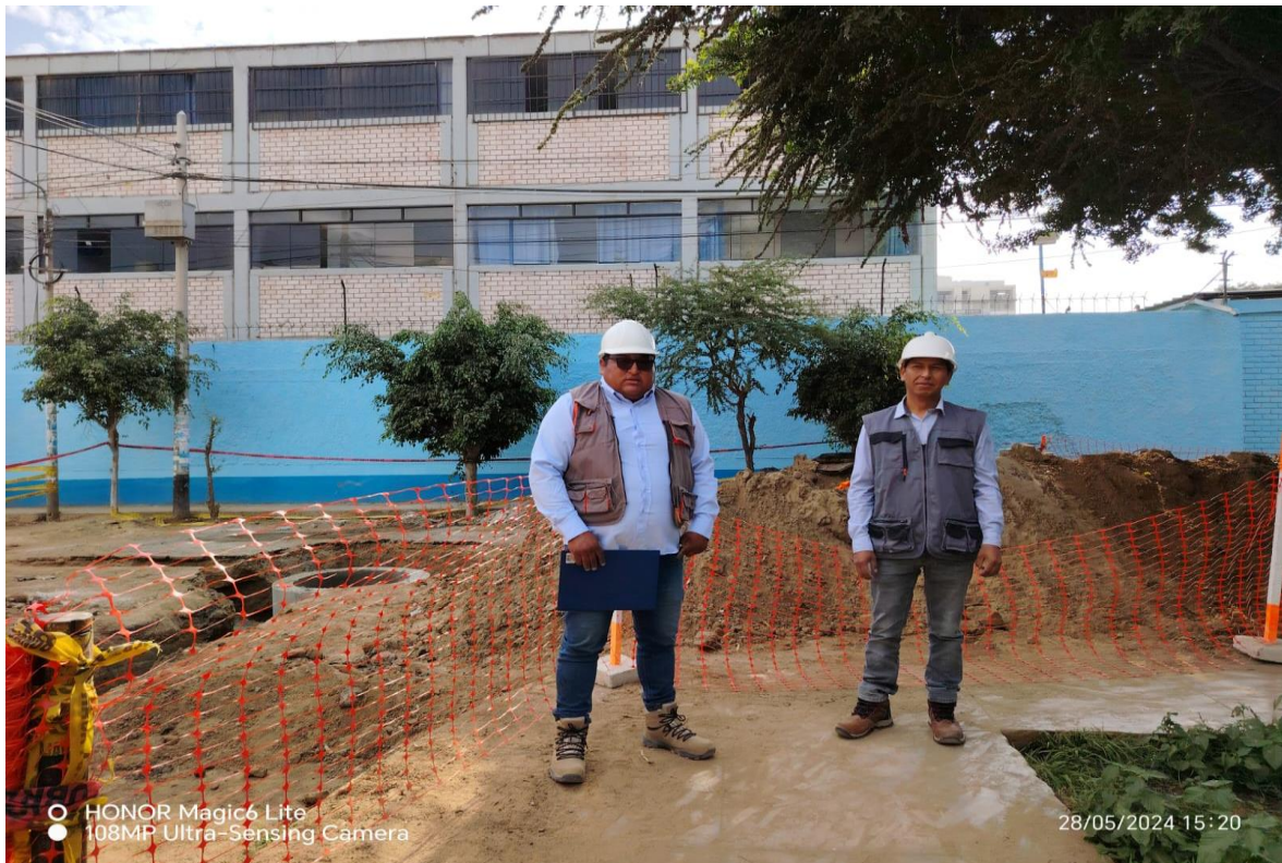
FIGURA 9: Inspecciones de daños y peligros en el proyecto de alcantarillado
