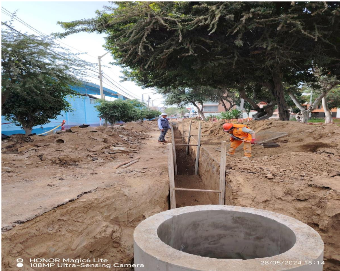
FIGURA 4: Limpieza de zanjas para la colocaciones de tuberías
