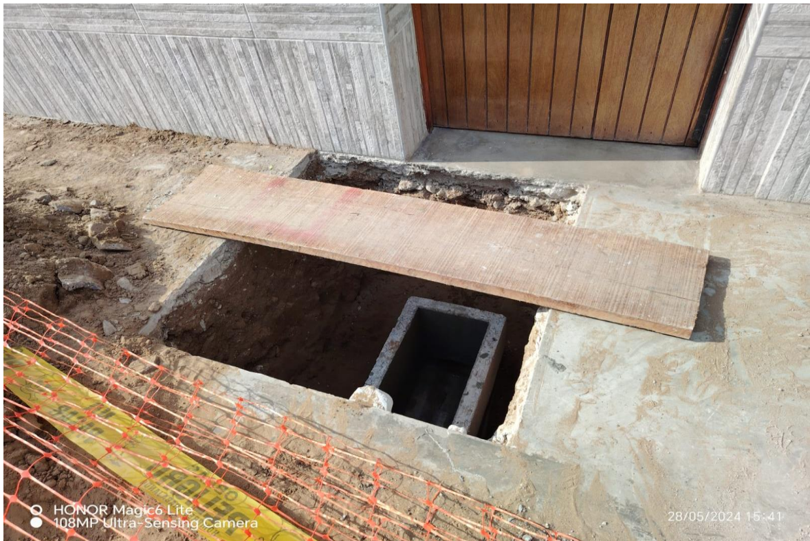
FIGURA 13: Colocación de cajas de desagüe
