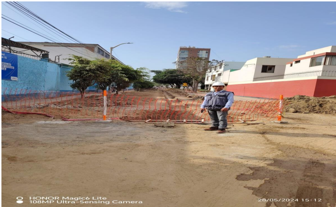
FIGURA 1: Inspección de señalizaciones
