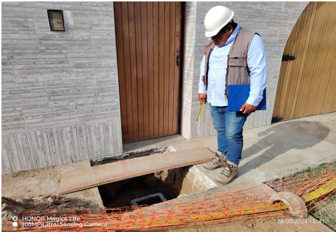
FIGURA 15: Verificación de cajas de desagüe
