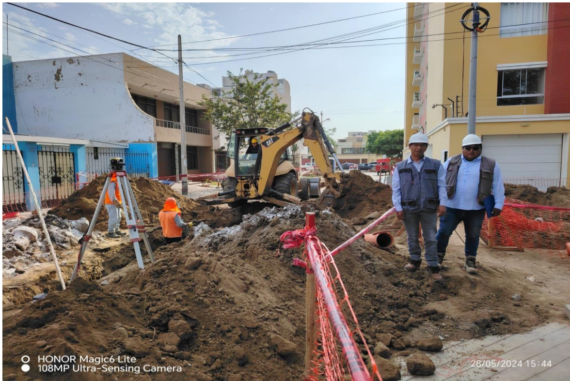
FIGURA 17: Nivelación topográfico para las respectivas excavaciones de desagüe
