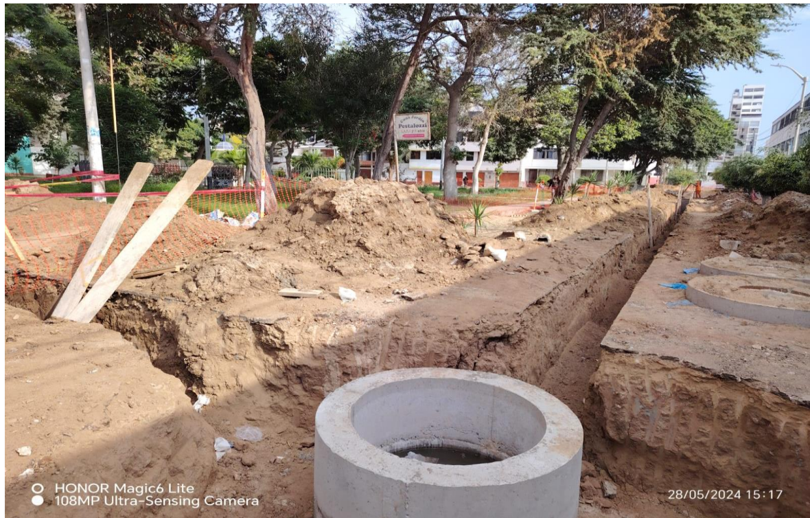
FIGURA 5: Excavación de zanjas de alcantarillado
