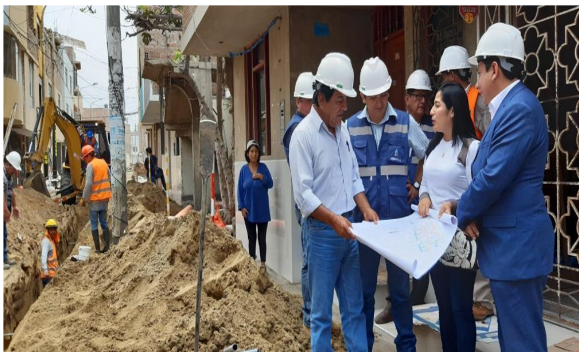
FIGURA 20: Supervisión y verificación de zanjas
