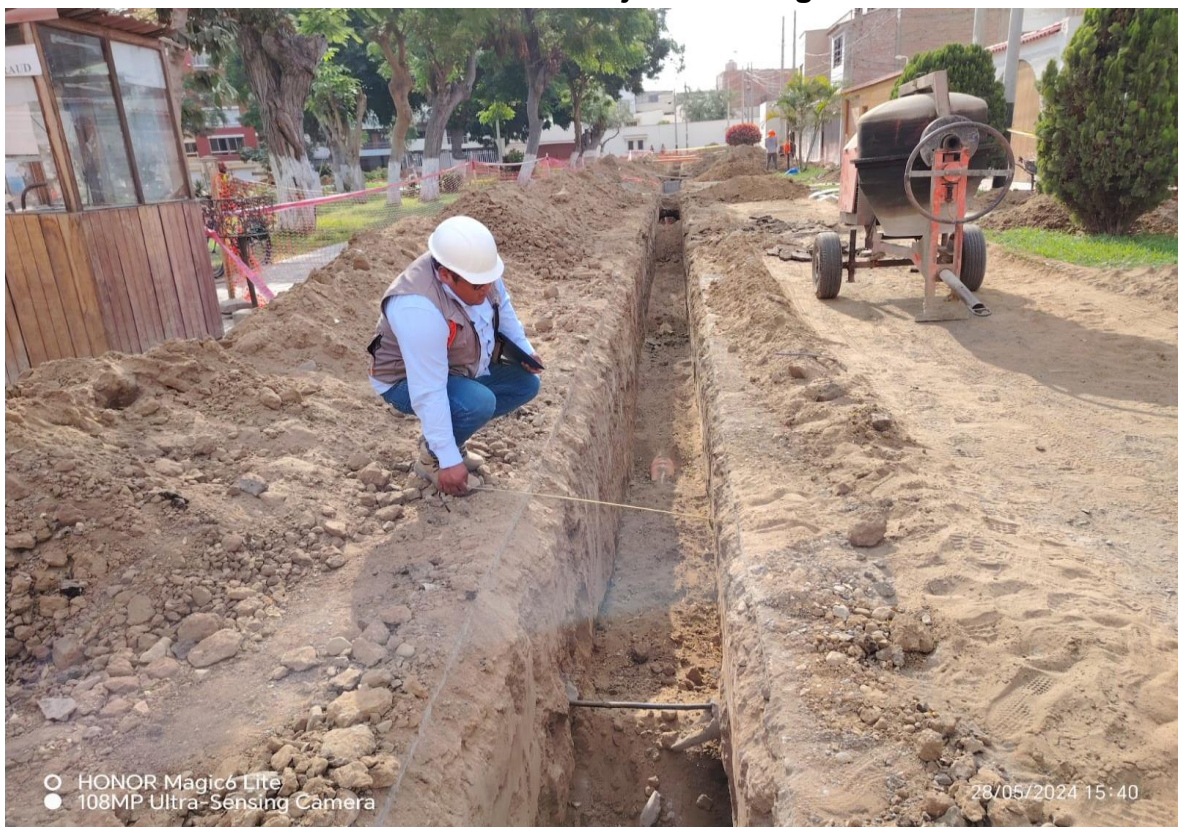
FIGURA 14: Verificación de medidas zanjas de desagüe
