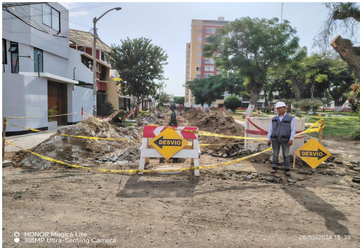
FIGURA 19: Señalizaciones de las zanjas de desagüe
