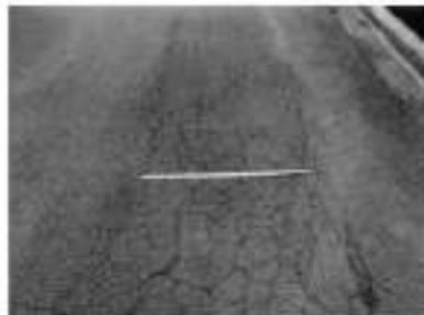
Figura 11.2 Piel de cocodrilo – Severidad Media
