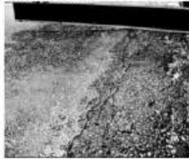
Figura 11.12 Abultamiento y Hundimiento – Severidad alta
