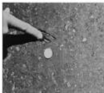
Figura 11.5 Exudación – Severidad Media
