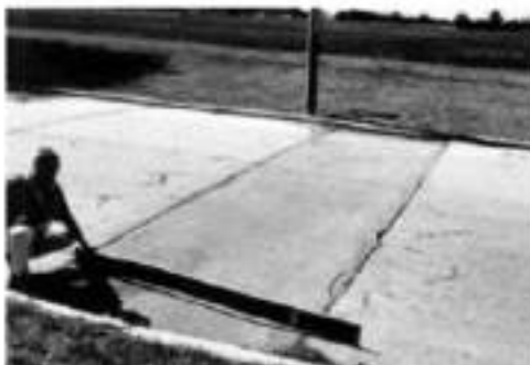
Figura 11.29 Parches – Severidad media
