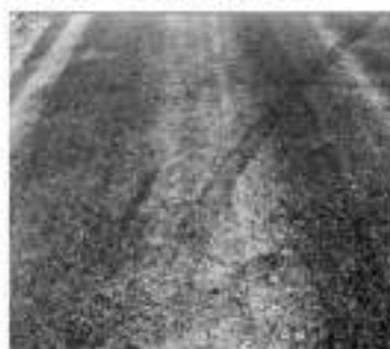
Figura 11.4 Exudación – Severidad Baja
