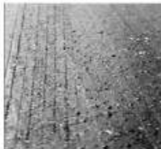
Figura 11.6 Exudación – Severidad alta
