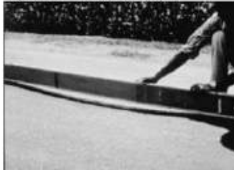
Figura 11.17 Depresión – Severidad media
