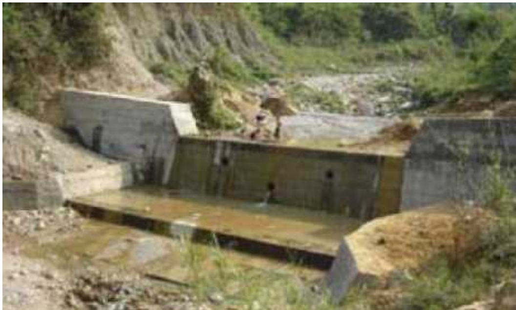
ILUSTRACION 9: VISTA PRESA SABO
