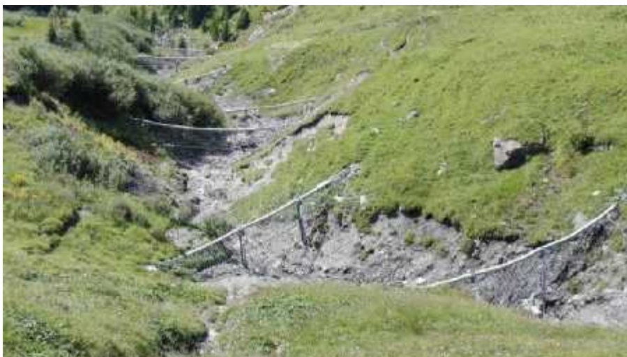
ILUSTRACION 7: COLOCACION BARRAS FLEXIBLES
