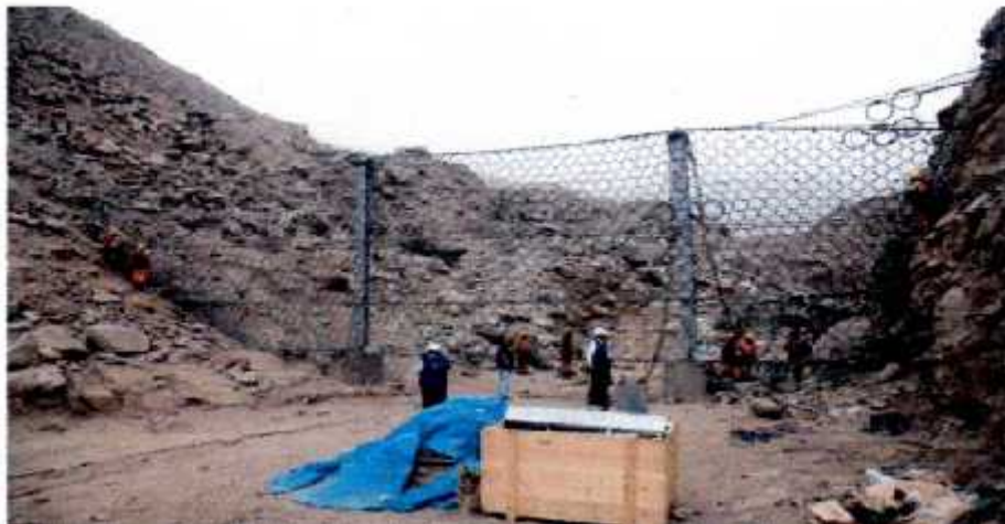
ILUSTRACION 6: COLOCACION BARRERAS FLEXIBLES
