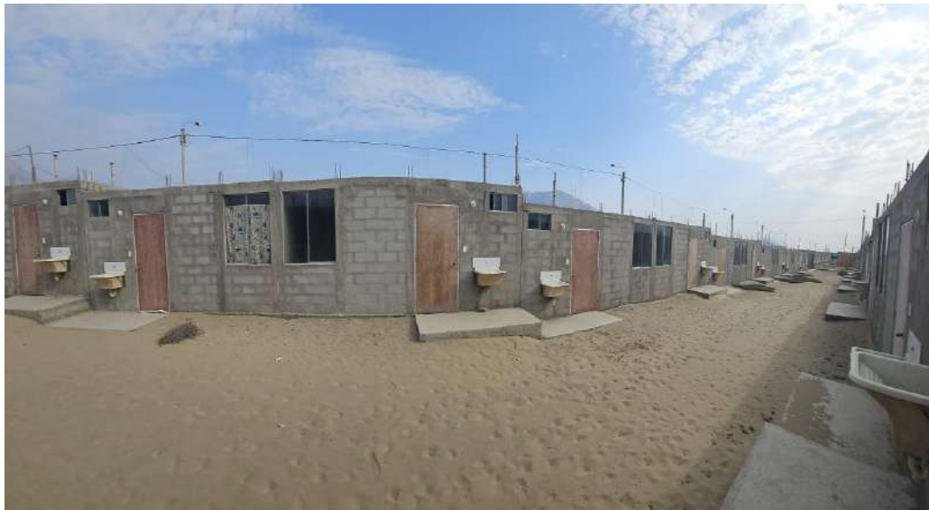
Figura 16: Zona trasera de los módulos
