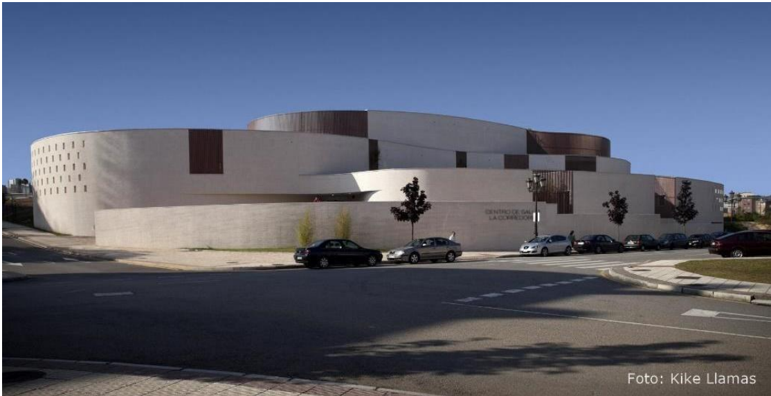
Figura N° 8: “Vista exterior Centro de Salud Mental de la Corredoria. “
