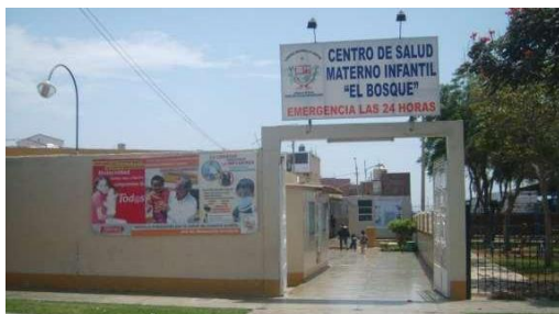
Figura N° 25: “Imágenes exteriores del Centro de salud El Bosque – Trujillo.”
