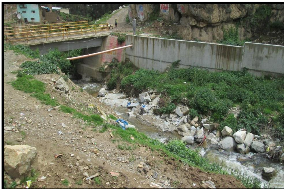
**Figura 6-1. Erosión y socavación**
