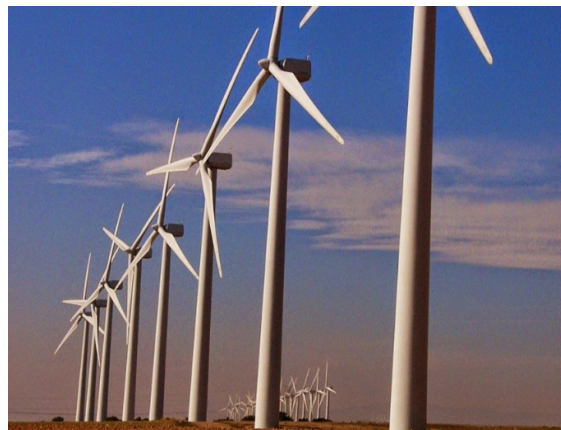
Fotografía N° 03 : Vista de aerogeneradores
