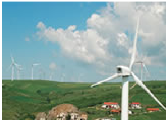
Fotografía N° 08 : Vista de equipos y viento
