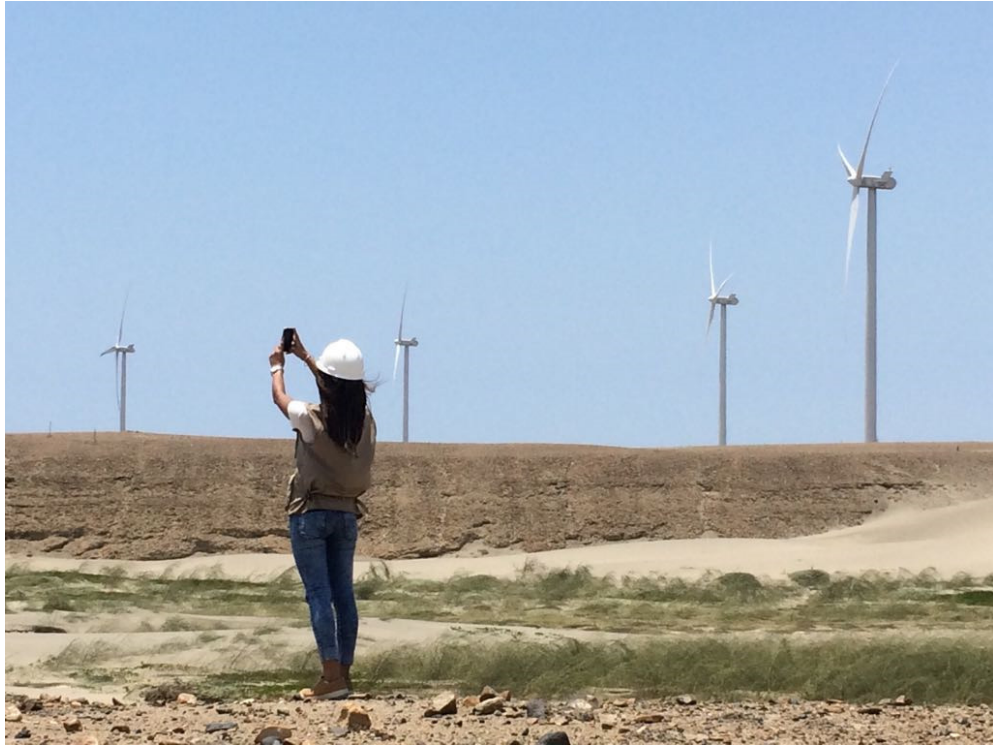
Fotografía N° 14 : Vista de Tesista calculando la velocidad del viento en la Central Eólica
