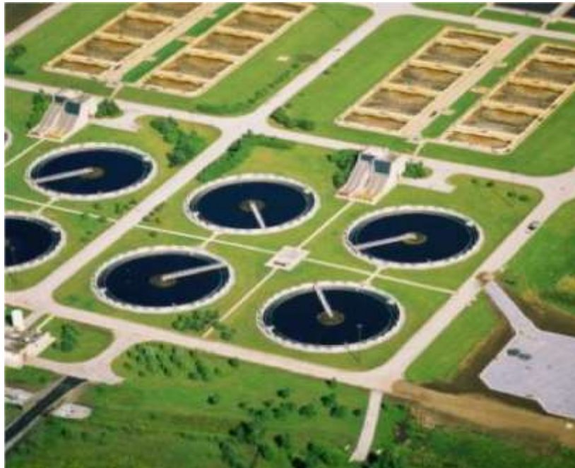
Fotografía N° 8 : Vista de una planta de tratamiento de Lodos Activados
