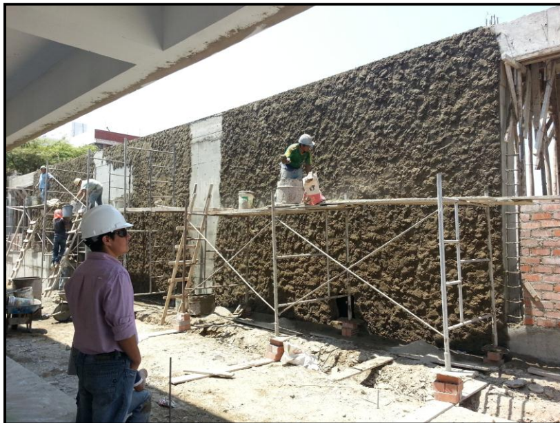
FOTO PROYECTO L. Tarrajeo de muros.
