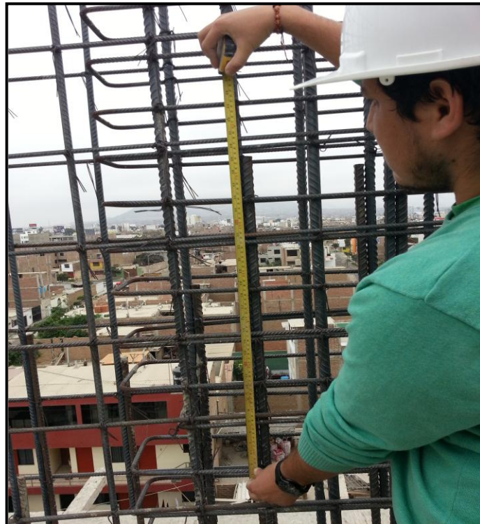
FOTO PROYECTO A. Verificación de longitud de traslapes e placas.
