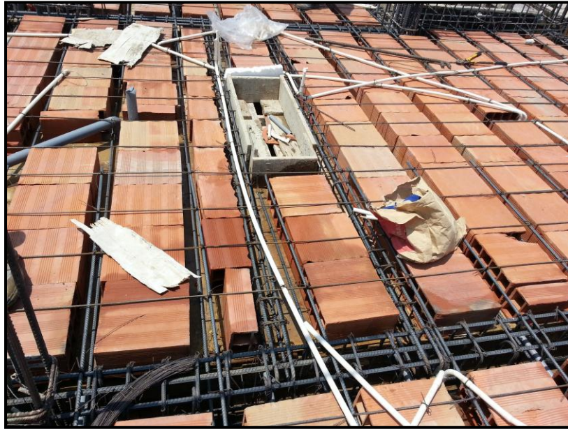
FOTO PROYECTO A. Preparación de losa aligerada para vaciado de concreto.
