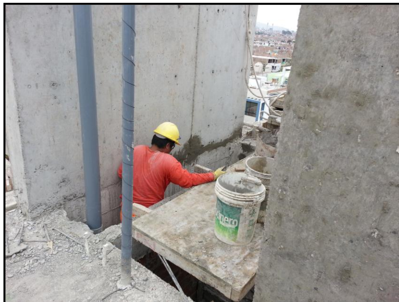
FOTO PROYECTO A. Resane de placas con mortero de cemento y arena sin el uso de ningún aditivo
