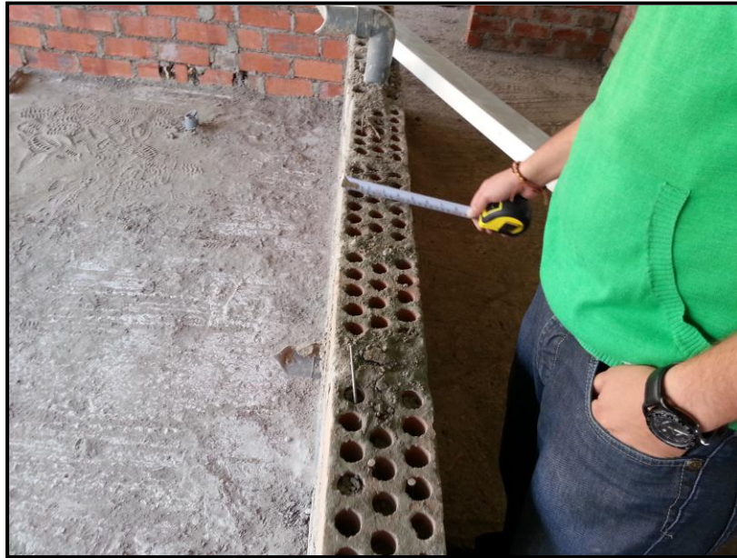
FOTO PROYECTO A. Verificación de medidas de las unidades de albañilería.
