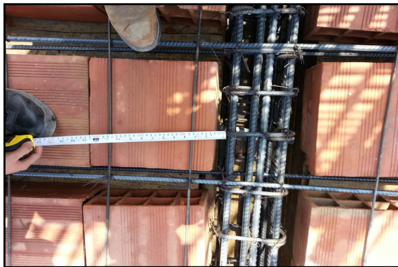
FOTO PROYECTO A. Ladrillo de techo adyacente a vigas, volteados para evitar ingreso de concreto en sus aberturas.
