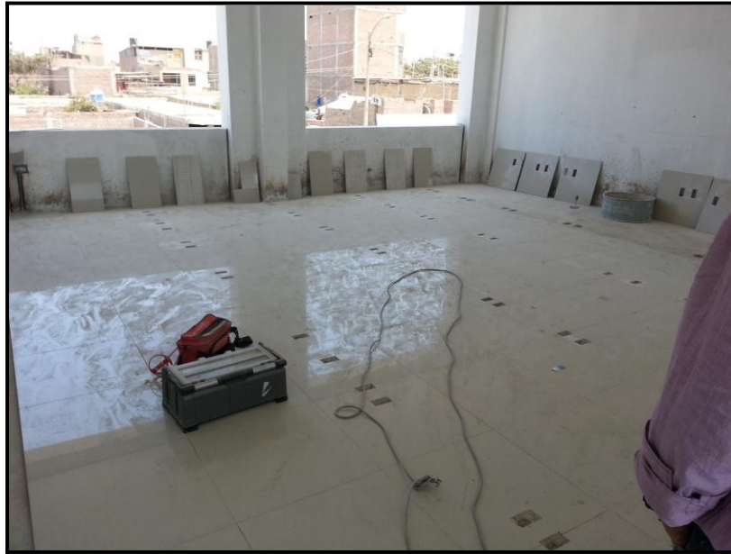
FOTO PROYECTO L. Colocación de piso de porcelanato.
