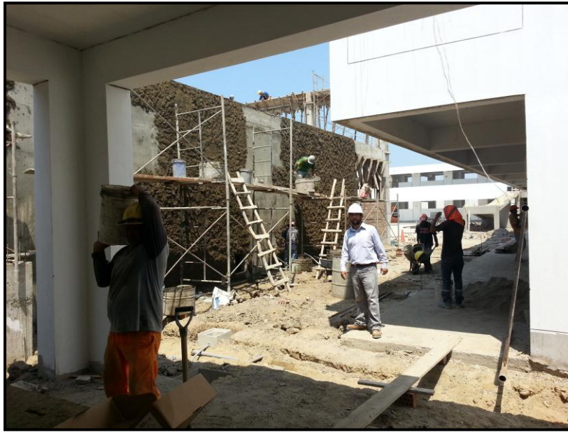
FOTO PROYECTO L. Tarrajeo de muros.
