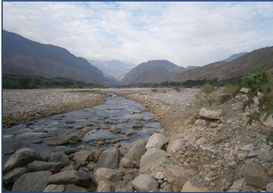
Fuente: Perfil de pre- inversión “Mejoramiento Del Puente Chuquillanqui, Distrito De Lucma, Provincia De Gran Chimú, Región La Libertad”
