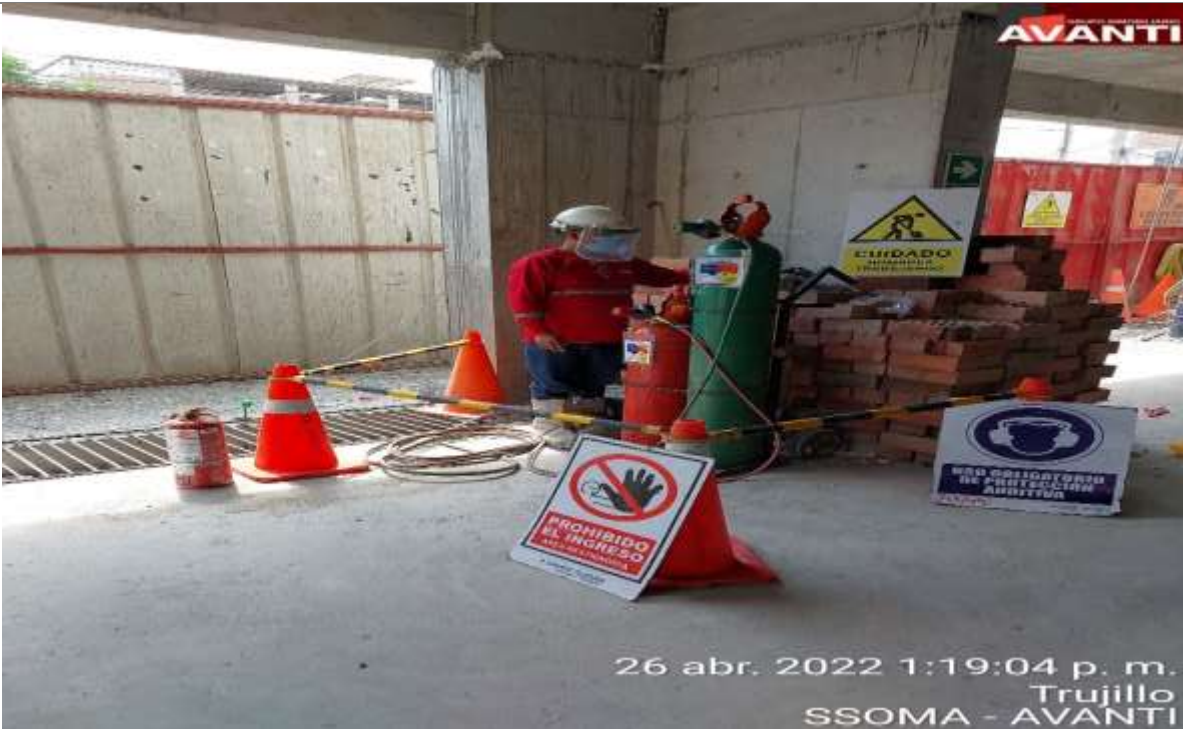
Implementación de equipos, señalización
