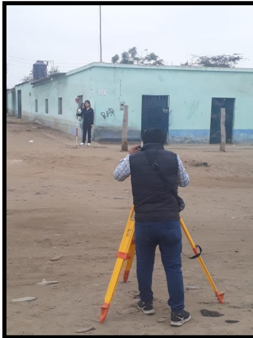
Se da inicio del trabajo tomando el punto de la vereda esquinada de la manzana.
