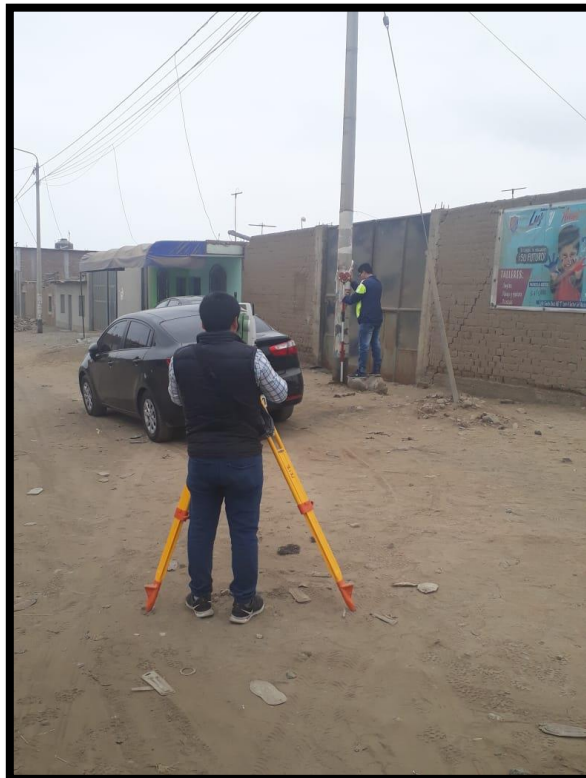
Se da lectura a medir puntos en la ubicación de postes.
