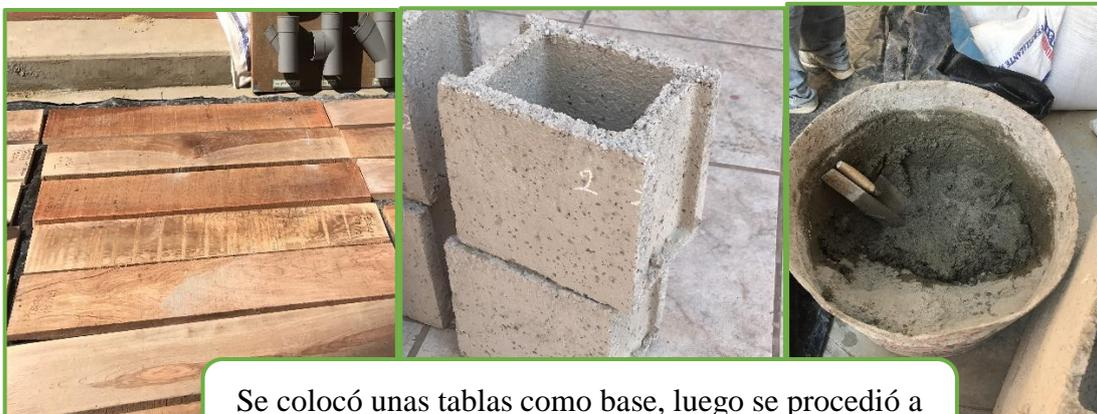
Se colocó unas tablas como base, luego se procedió a cortar el ladrillo y a realizar la mezcla.
