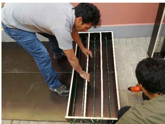
Foto N° 26: Sujeción de moldes
