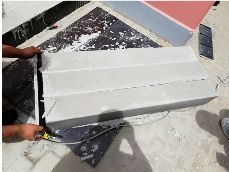
Foto N° 14: Desencofrado de vigas
