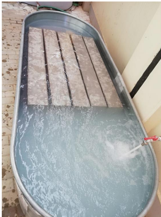
Foto N° 15: Curado de vigas
