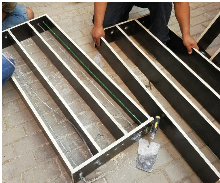
Foto N° 10: Colocación de sogas PET
