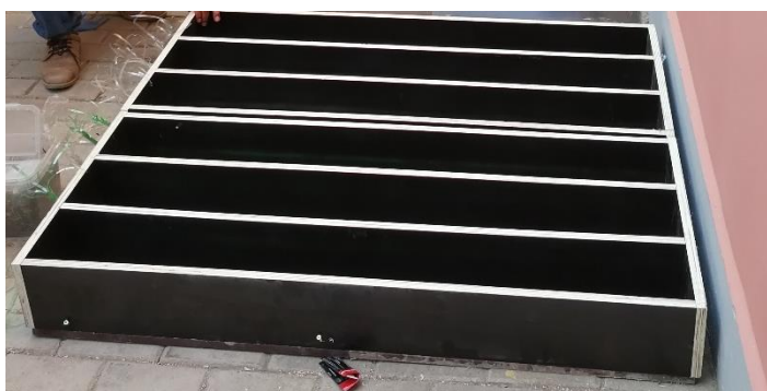
Foto N° 9: Molde de encofrado
