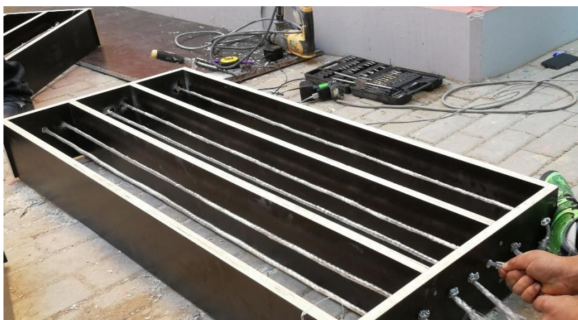
Foto N° 11: Fijación de sogas PET en moldes.
