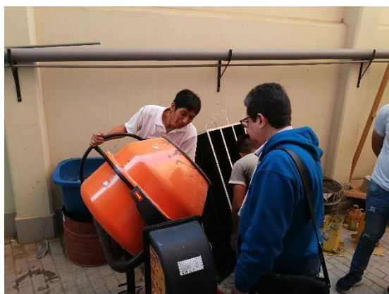
Foto N° 27: Preparación de mezcla
