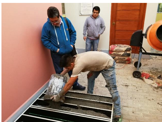
Foto N° 28: Vaciado del concreto en moldes
