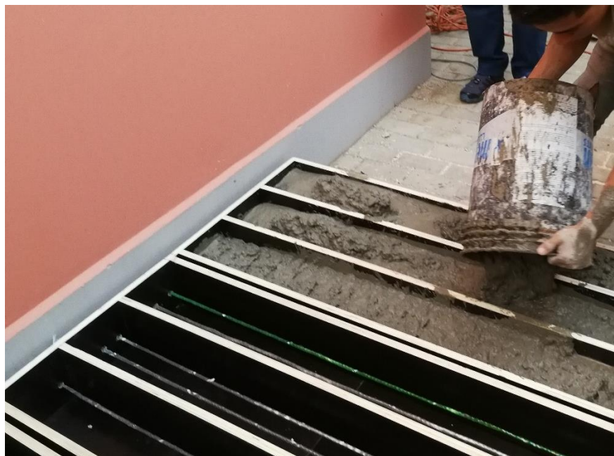
Foto N° 13: Vaciado del concreto
