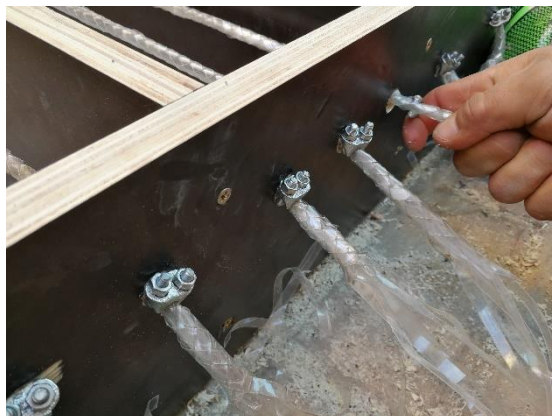
Foto N° 25: Colocación de fibras PET (tensionadas)
