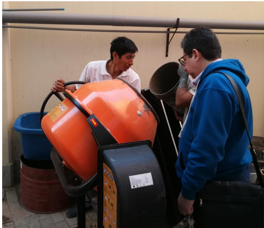
Foto N° 12: Preparación de mezcla.
