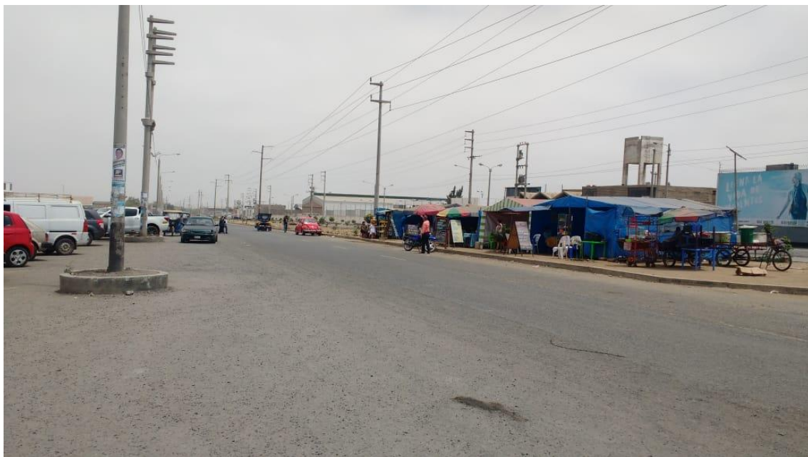
Mal uso de la berma central, por parte del comercio ambulatorio.
