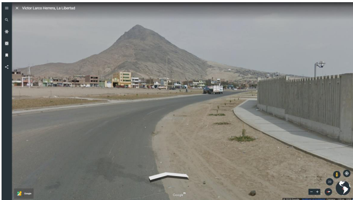
Vista en panorámica de la Arteria 2 – Secundaria Suburbano II
