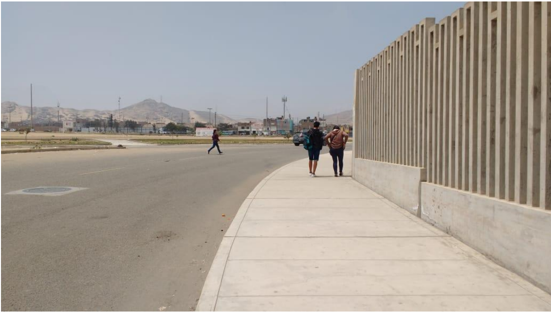
No existe señalización en la vía.
