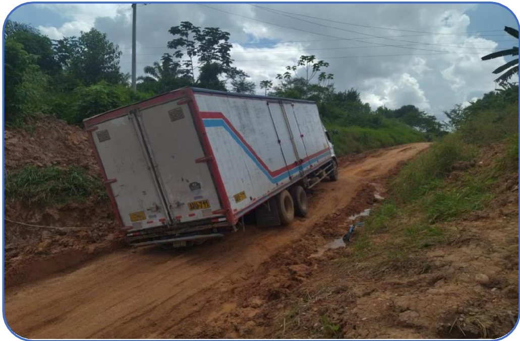
Fotografía 09: Observamos la principal problemática del camino vecinal el cual es la transitabilidad.
