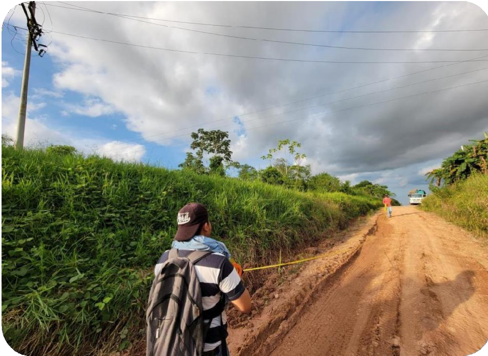
Fotografía 07: Medición longitudinal de la vía, para la colocación del estacado con las progresivas correspondiente.
