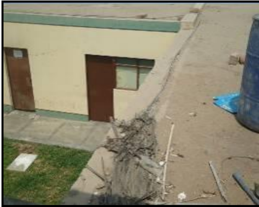
Fotografía nº 17: Utilización de depósito en la azotea
