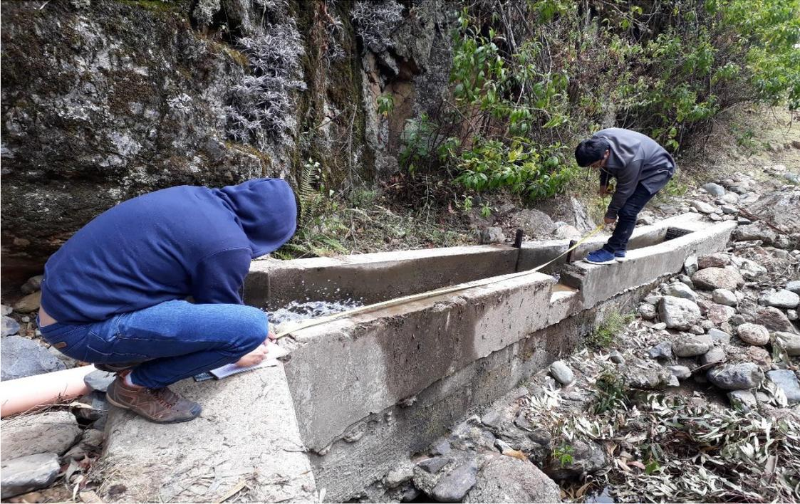
**Fotografía N° 8: Canal de Derivación con rejilla oxidada**
