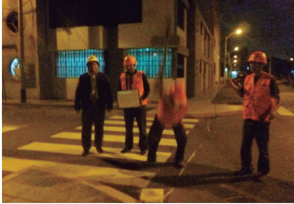
FOTO A-5-27: Vista panorámica de la línea MASW (LW-10), ubicada en la Urb. Upao II
