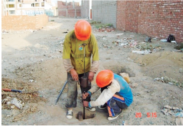
FOTO A-5-13: Vista del sondeo de exploración con el equipo de penetración dinámica ligera DPL-05, hasta la profundidad de 5.00 m., ubicada en MZ. “K-1”, Lote 22, Urb. Covicorti.
