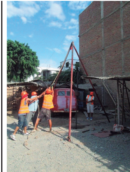
FOTO A-5-18: Vista del sondeo de exploración con el equipo de penetración estándar SPT-3, hasta los 6.75 m., ubicada en Mz. "E" – Lote 17 – Urb. Ingeniería II.
