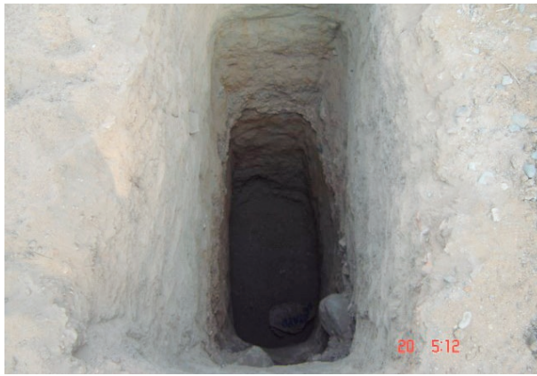
FOTO A-5-08: Vista del perfil estratigráfico de la calicata C-19, a la profundidad de 3.00 m. Nótese la presencia conformado inicialmente por material de relleno orgánico suelto, luego sigue arena pobremente graduada SP, no plástica, de poca humedad y de compacidad media con la presencia de limos conforme nos vamos profundizando. No se nota el NAF a la profundidad explorada.
