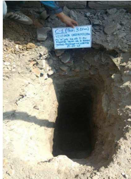
FOTO A-5-02: Vista del perfil estratigráfico de la calicata C-1, a la profundidad de 3.00 m. Nótese inicialmente la presencia del relleno superficial conformado por suelo orgánico hasta los 65 cm, luego la presencia de arenas arcillosas SC, de compactación media y poca humedad, luego sigue arcillas de baja a mediana plasticidad CL, de consistencia media y regular humedad. No se nota la presencia del NAF a la profundidad explorada.
