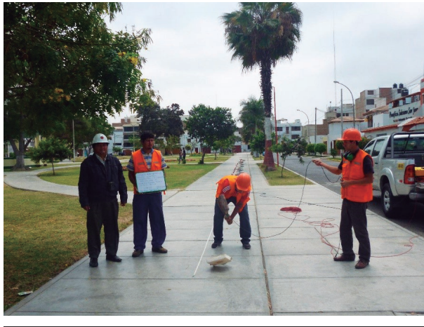
FOTO A-5-22: Vista panorámica de la línea MASW (LW-02), ubicada en la Urb. El Recreo.
