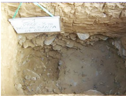
Foto 3. 1 Excavación de calicata realizada por SL DE INGENIERIA EIRL en la Av. Prolongación Santa – Trujillo
