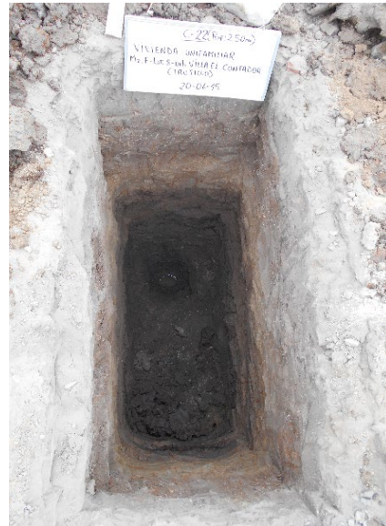
FOTO A-5-10: Vista del perfil estratigráfico de la calicata C-22, a la profundidad de 3.00 m. Nótese el tipo de material superficial, conformado por material de relleno, luego arena Limosa SM, de baja plasticidad, de poca a regular humedad, de compactación media y a continuación arcillas de baja plasticidad CL. con presencia de gravas menudas de 1/2” conforme nos vamos profundizando, de regular humedad, de consistencia blanda a media. Se nota el NAF a la profundidad de 2.20 m.
