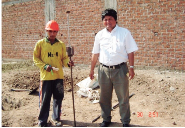
FOTO A-5-15: Vista del sondeo de exploración con el equipo de penetración dinámica ligera DPL-12, hasta la profundidad de 5.00 m., ubicada en Mz. “E” - Lote 17, Urb. Ingeniería II
