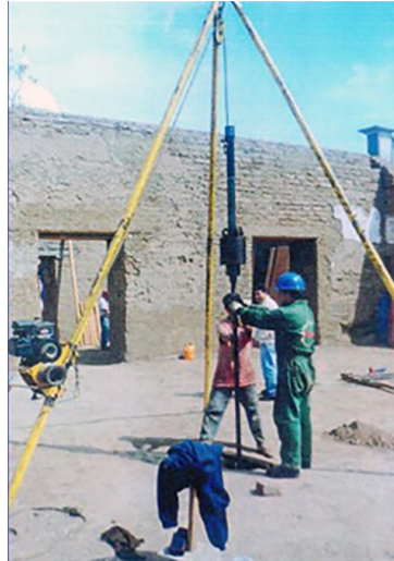
Foto 3. 3 Ensayo de penetración estándar (SPT) realizado por la UPAO en el Jr. Independencia – Centro Histórico de Trujillo
