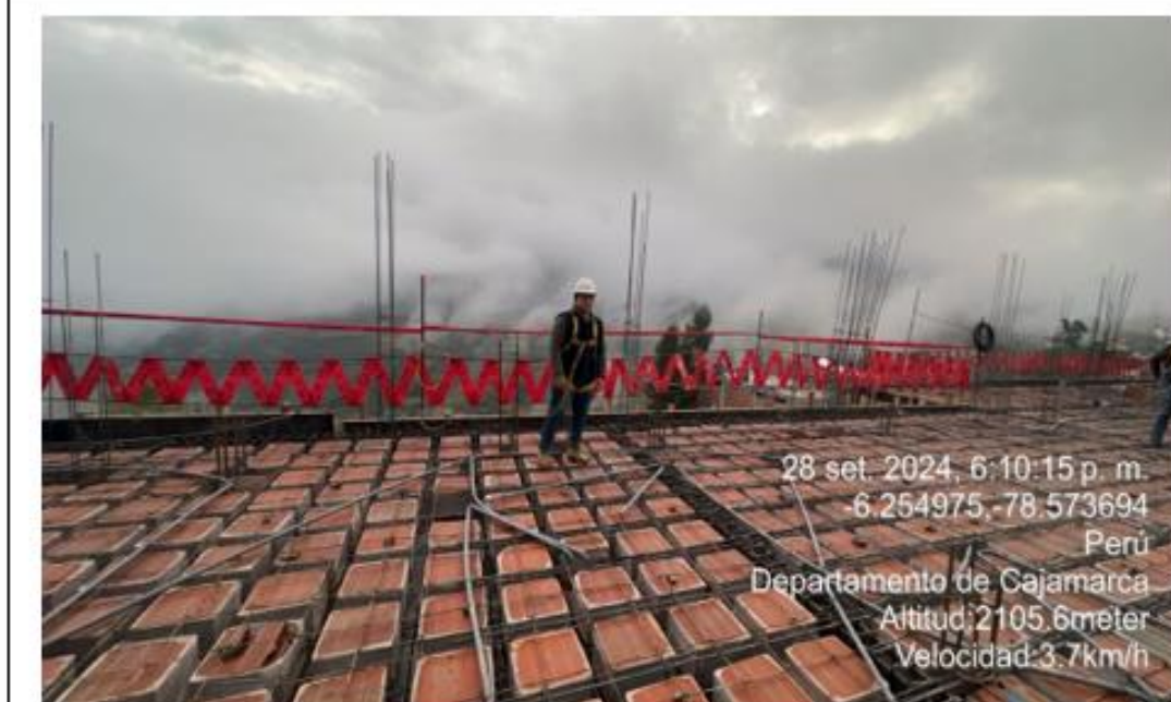
FOTO 04. Verificación de losa aligerada previo vaciado de concreto
