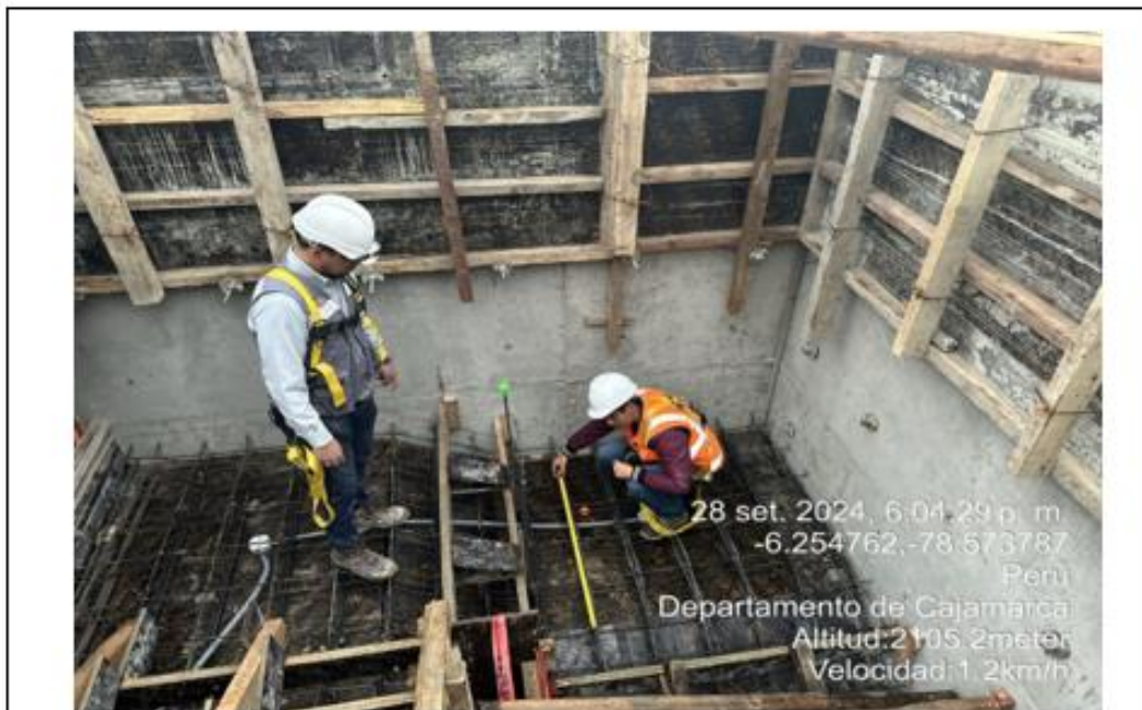
FOTO 01: Verificación de acero longitudinal en escaleras del Piso 02
