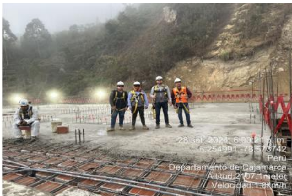
FOTO 02: Verificación de vaciado de losa maciza en Piso 02
