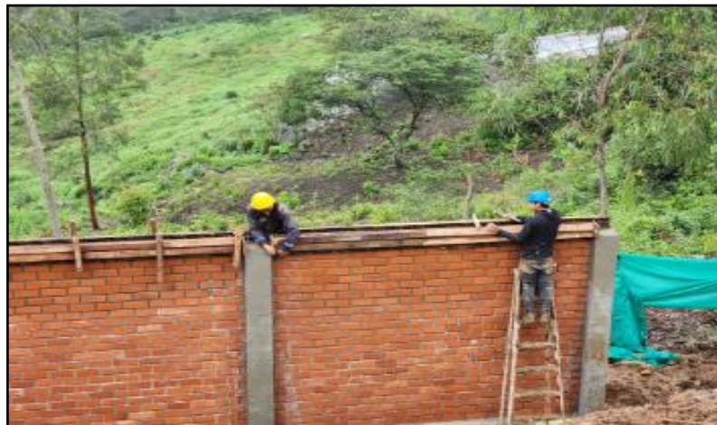
Encofrado de viga solera en cerco perimetral
