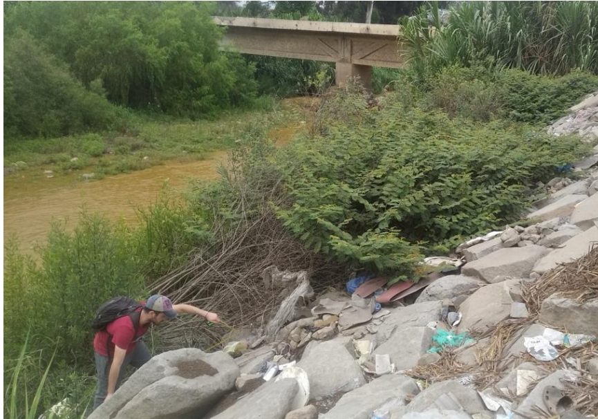
Fotografía 05: Medición de rocas de enrocado existente (Noviembre 2023).
