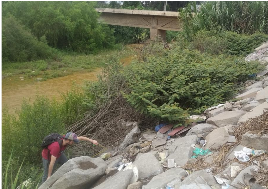
Fotografía 06: Medición de calzada de puente (Noviembre 2023).
