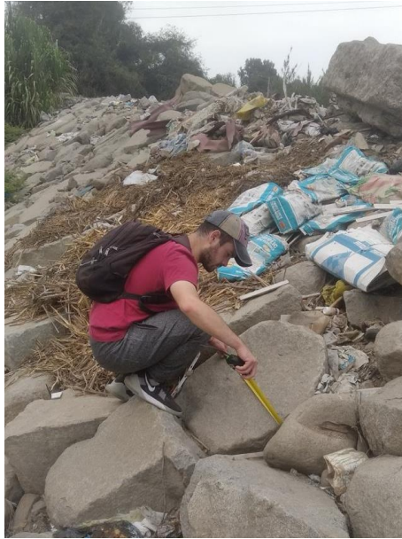
Fotografía 04: Medición de rocas de enrocado existente (Noviembre 2023).
