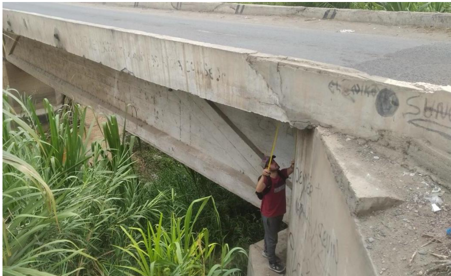
Fotografía 07: Medición de la subestructura del puente (Noviembre 2023).
