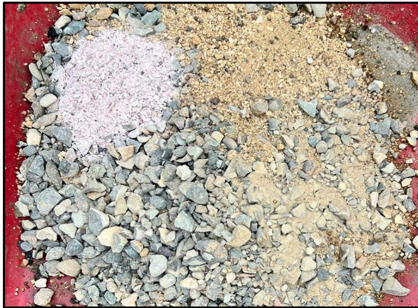
Figura 10. Preparación de materiales para la elaboración del concreto
