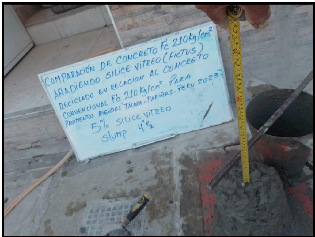
Ensayo de asentamiento – Concreto f_c=210\text{kg/cm}^2 + 5%– Consultgeopav S.A.C
