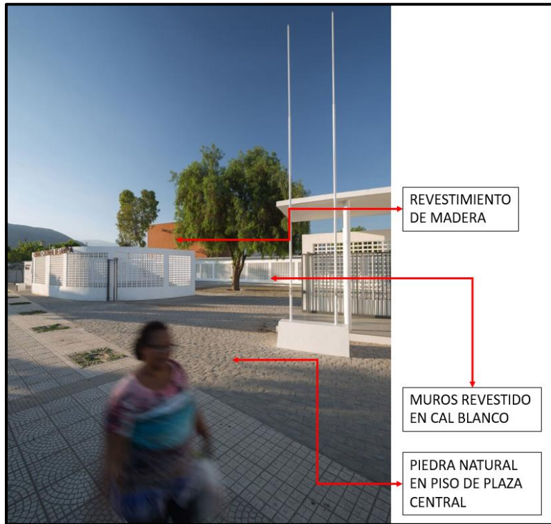
Figura 68 Materialidad del Centro Lampa
