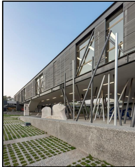
Figura 78 Pilares inclinados metálicos
