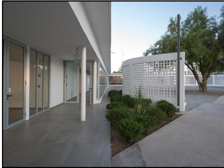
Figura 63 Patio central vista desde interior del centro
