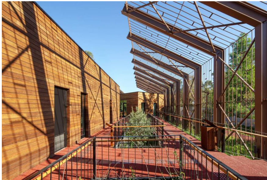
FIGURA N° 75: Vista exterior del edificio
