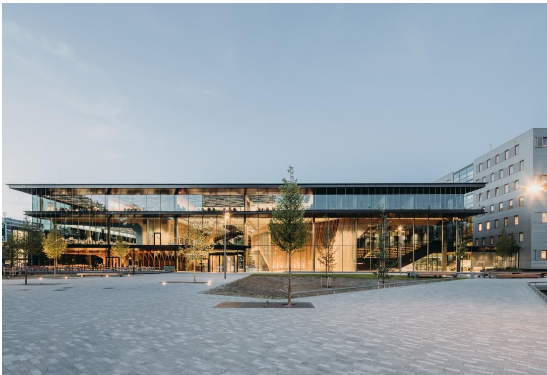
FIGURA N° 64: Vista exterior del edificio
