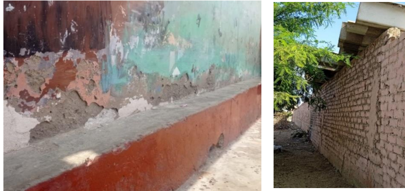
Figura 32. Vista interior y exterior del muro de contención Fuente: Visita al colegio por el equipo
