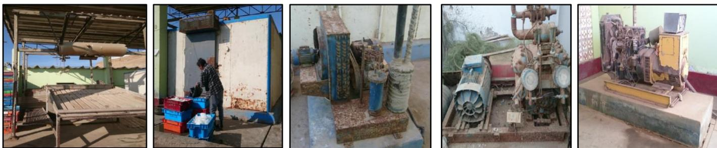
Imagen N°15: Maquinaria de Frío en pésimas condiciones
