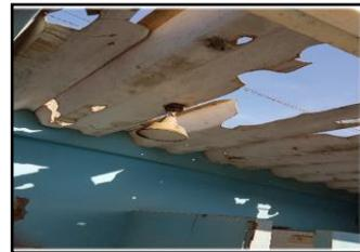
Imagen N°14: Cubiertas colapsadas
