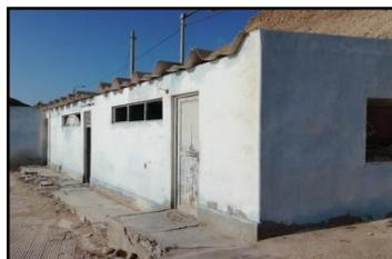
Imagen N°13: Pisos y veredas en mal estado
