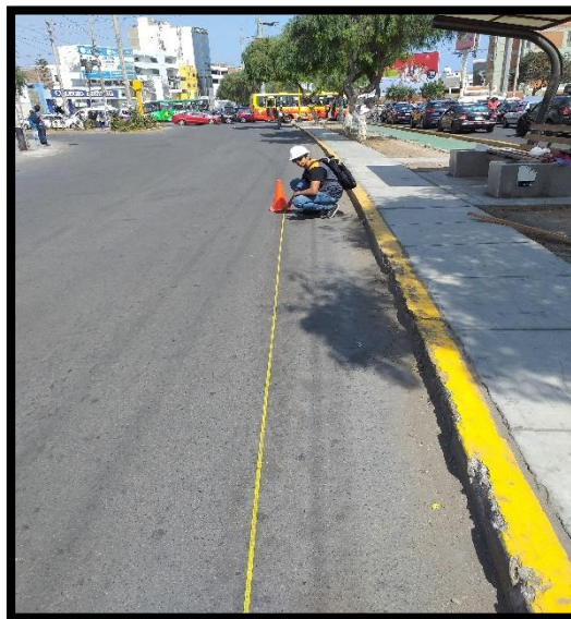
Imagen 16: vista general entre av. Costa Rica y av. América Sur.
