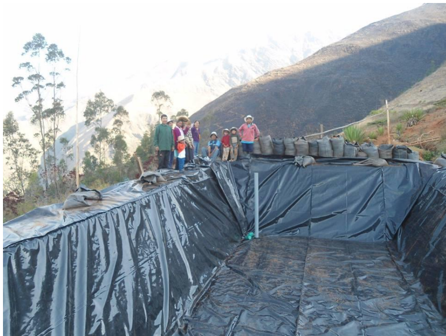
Figura 22. Instalación de geomembrana para el riego de granadilla, caserío Yacat, distrito de Charat, Otuzco, La Libertad, fecha 23-05-16
