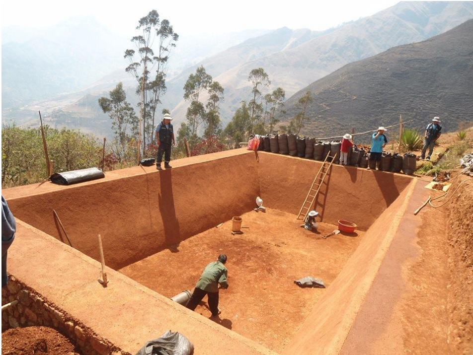
Figura 21. Construcción de reservorio para el riego tecnificado por microtubos, caserío Yacat, distrito de Charat, Otuzco, La Libertad, fecha 20-05-16
